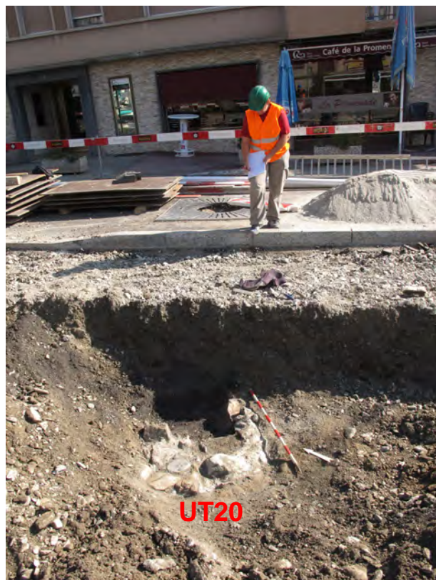
Fig. 25. Sion. Avenue Ritz. UT20: vestige d'un regard ou d'une bouche d'égout. Vue depuis l'ouest.
