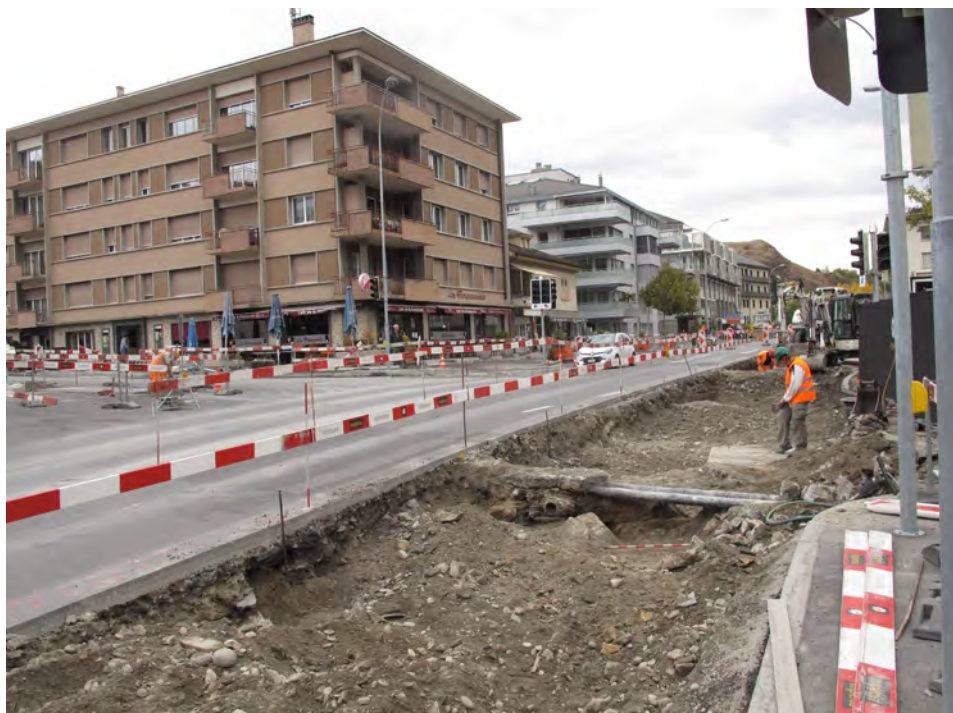
Fig. 1. Sion. Avenue Ritz. Vue générale de l'une des étapes des travaux. Vue du sud-ouest.
