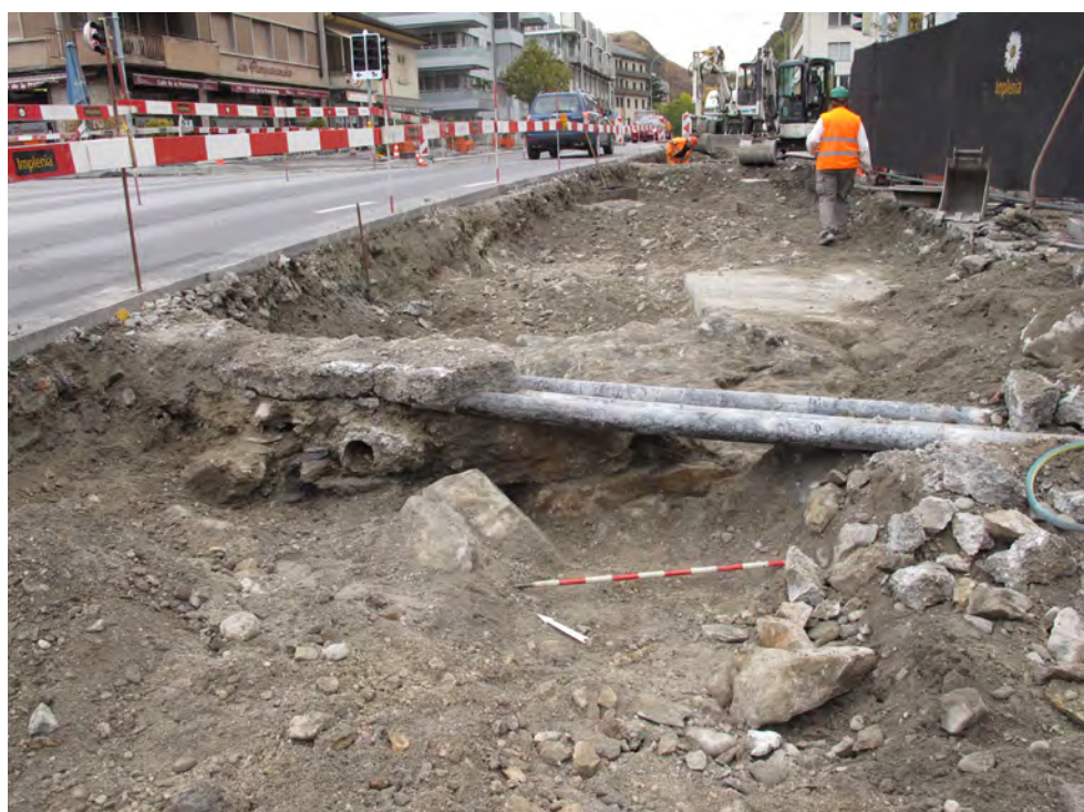
Vue des travaux, depuis l'ouest, à la hauteur de la «Porte de Savièse»
