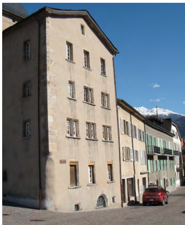
Fig. 17. Sion. Avenue Ritz. Maison à l'angle de la rue de Savièse et de l'avenue Ritz. L'arc qui forme le cadre de la fenêtre de cave comporte une clé de voûte gravée de 1538. il s'agit peut-être du linteau arqué d'une ancienne porte d'entrée de la maison.
