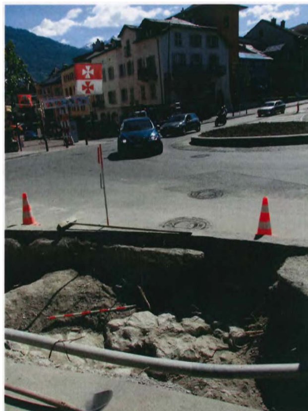
Vue des travaux, depuis le nord-est.
