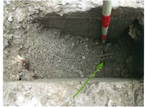
Fig. 13. Sion, Avenue Ritz. Détail de la canalisation de béton et des gaines renfermant les câbles électriques posées au fond du coffrage.
