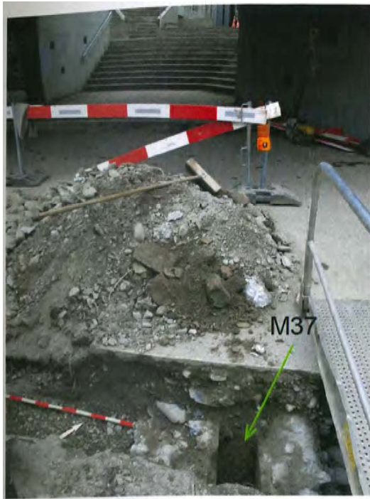
Fig. 12 Sion, Avenue Ritz. UT37: canalisation électrique du début du 20 e siècle sur le bord de la rue ancienne appelée aujourd'hui Rampe St-Georges. Vue du sud.
