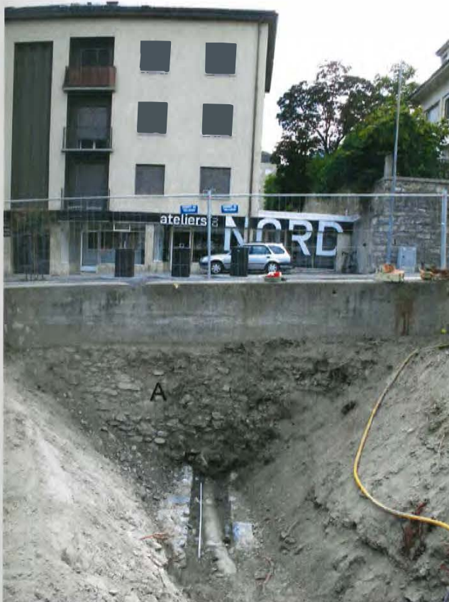
Fig. 10. Sion. Avenue Ritz. Canalisation maçonnée UT53, et face arrière (A) d'un mur maçonné construit contre terre qui pourrait être une digue ancienne de la Sionne. Vues de l'est.
