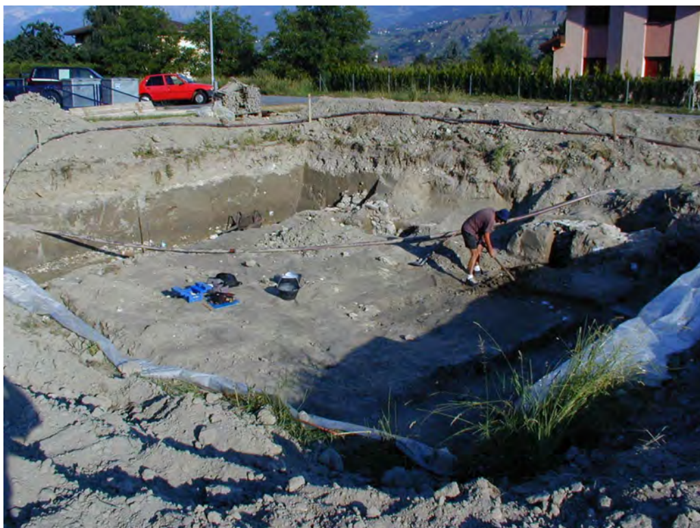
Fig. 2. Bramois, maison Pitteloud. Vue du chantier, depuis l'est. Le pourtour de la zone est excavé plus profondément au bas des profils.
