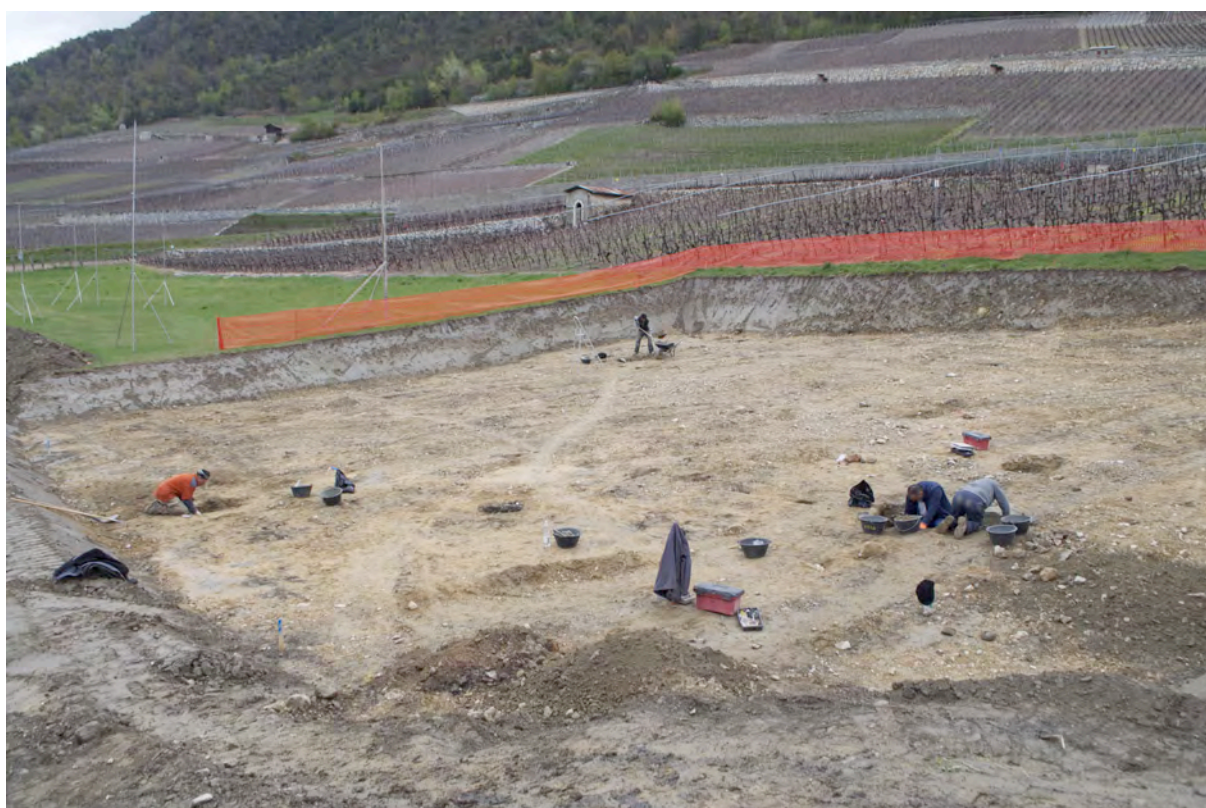
Vue générale du chantier depuis l'ouest.
