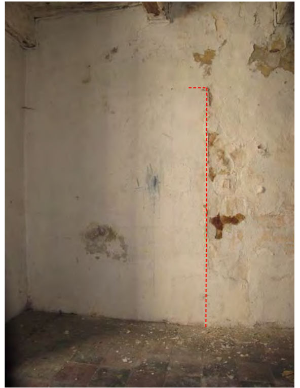
Fig. 23 Sion, Platea. Cuisine R3a, paroi est. Trace d'une porte bouchée, qui atteste un système d'accès aux étages différent de l'actuel.
