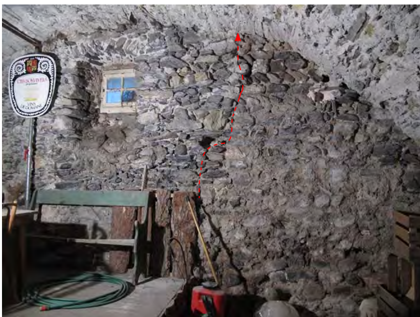
Fig. 15 Sion, Platea. Cave P2a, paroi est. Limite verticale entre deux maçonneries, la plus récente comprend la fenêtre et moule l'intrados de la voûte. La plus ancienne (à droite, brunie) est moulée par la maçonnerie de la voûte.
