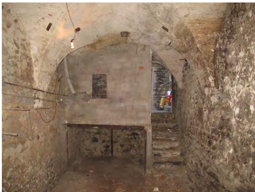
Fig. 7 Sion, Platea. Cave R1, paroi nord. La voûte couvre le crépi en pietra rasa de la paroi ouest de l'annexe : elle appartient à une phase de rénovation. Le cagibi en plots de ciment a détruit la retombée angulaire de la voûte.
