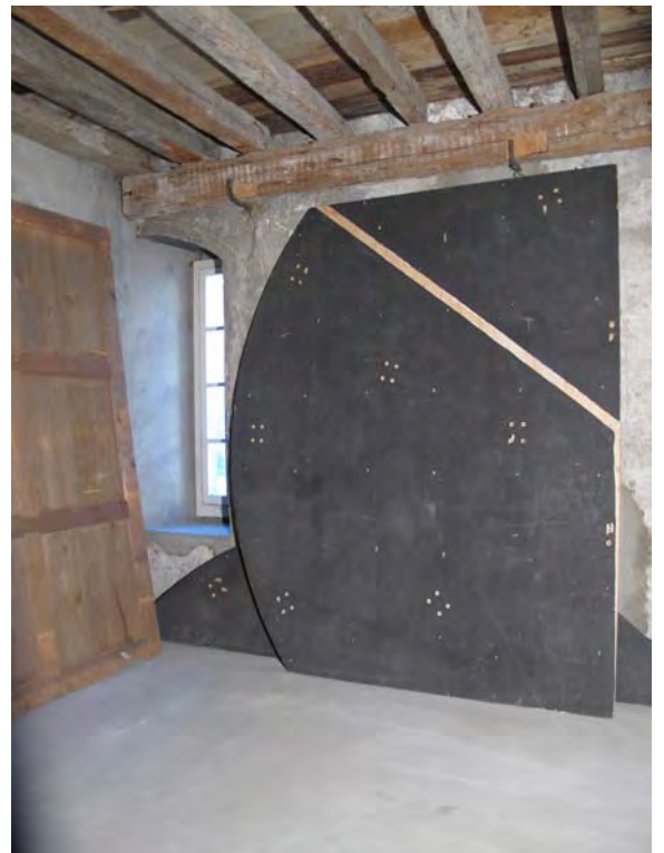
Fig. 24 Sion, Platea. Local P3a, angle nord-ouest. La paroi de refend ouest (cage d'escalier de l'annexe) coupe en deux la fenêtre à meneau. L'autre moitié de la fenêtre éclaire la cuisine du logement R4.
