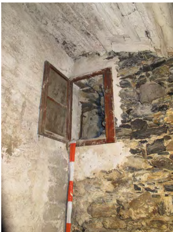
Fig. 4 Sion, Platea. Cave P1d, paroi nord. La « fenêtre » donne sur un canal vertical dont l'extrémité supérieure débouche en façade (niveau 0). La fenêtre résulte de la transformation du débouché inférieur du canal lors de la construction du mur de refend entre les caves P1d et P1c.
