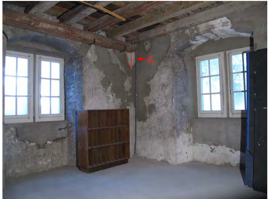
Fig. 25 Sion, Platea. Local P3a, angle nord-est. Le sol actuel se situe à une hauteur correcte par rapport aux fenêtres et à la voûte. A : retombée de la voûte d'arête.
