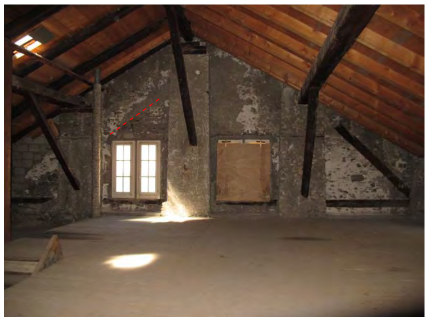
Fig. 39 Sion, Platea. Combles P5a, paroi nord. A : Trace d'un pignon plus bas que l'actuel.
