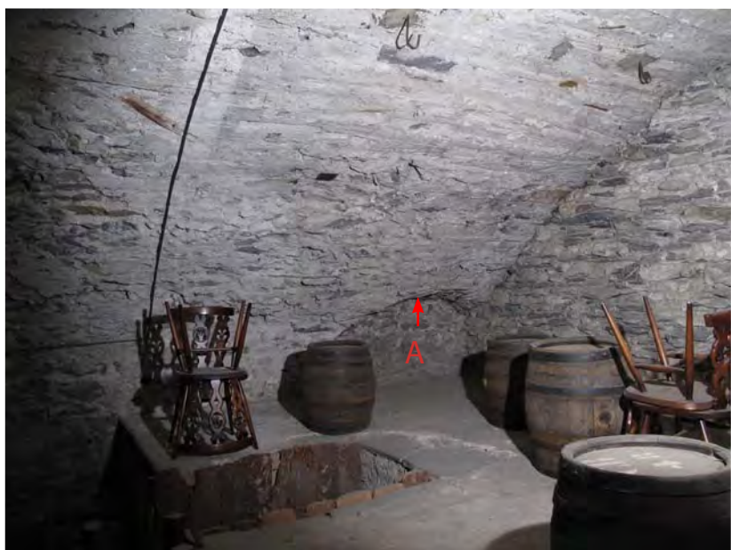
Fig. 14 Sion, Platea. Cave P2a, angle sud-ouest. Linteau arqué de la porte donnant primitivement à la grande cave arquée. Sa partie supérieure a été bouchée lors de la subdivision de l'espace en deux caves superposées. A : Le voûtain ne semble pas avoir été aménagé dès le départ avec la voûte.
