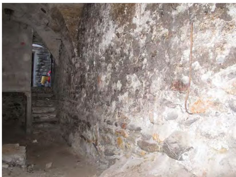
Fig. 8 Sion, Platea. Cave R1, paroi est (= pied de la façade occidentale de la tour), vue vers le nord. Le ressaut indique le niveau de marche primitif de la cave ; il se situe env. 60 cm sous le seuil de porte. Dans sa moitié nord, la cave a été excavée sur près d'1.00 m de profondeur.
