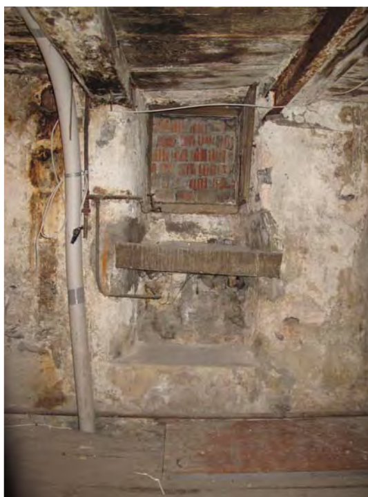
Fig. 11 Sion, Platea. Local R2, paroi ouest. Fenêtre dont l'embrasure a été réduite puis équipée d'un évier. Ouverture bouchée lors de la construction du Casino.
