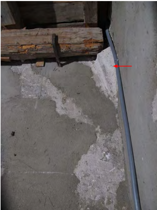
Fig. 26 Sion, Platea. Local P3a, plafond, angle nord-est. Départ de la voûte d'arête qui couvrait le local auparavant.
