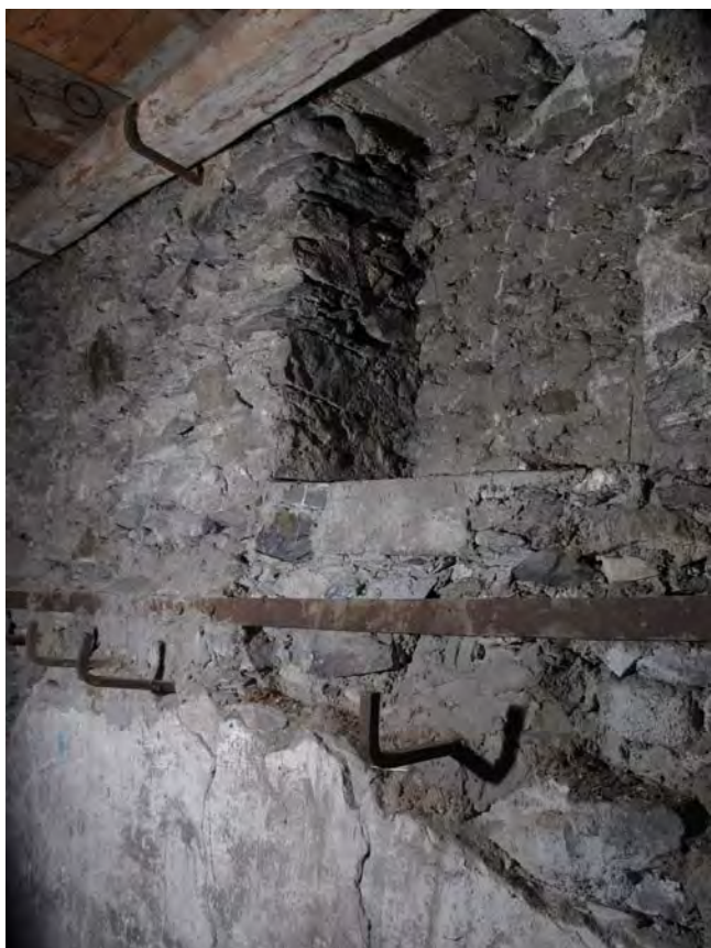
Fig. 34 Sion, Platea. Local P4a, paroi nord, vue vers le nord-ouest. La fenêtre possède un arc coffré et semble contemporaine du mur. Elle serait donc antérieure aux voûtes.
