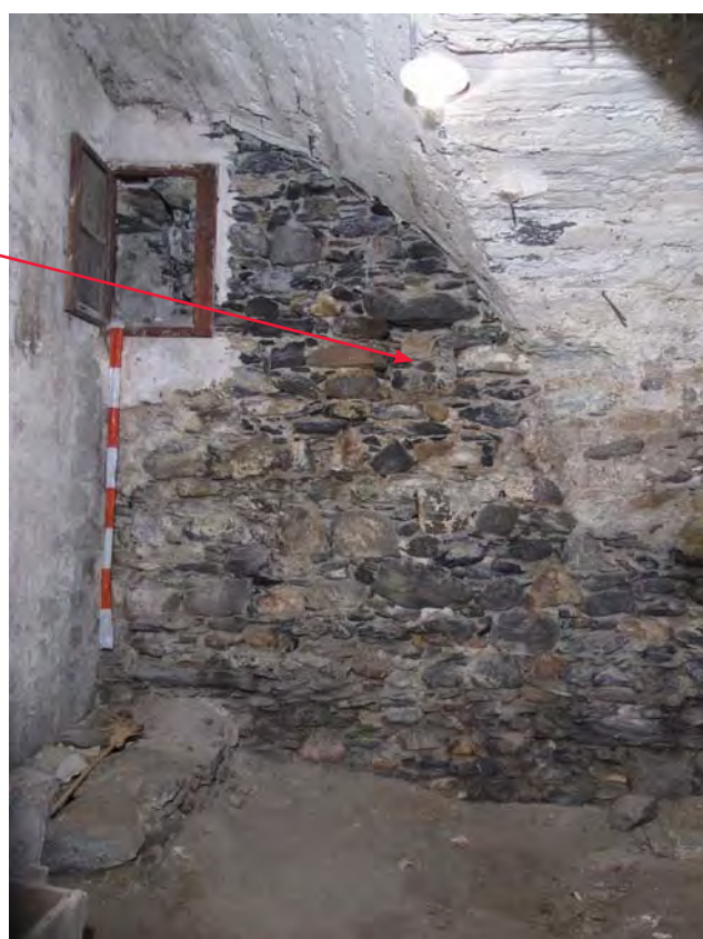
Fig. 3 Sion, Platea. Cave P1d, paroi nord. La maçonnerie est identique à celle de la paroi sud. Elle comprend d'origine la niche de logement (A) du sommier.
