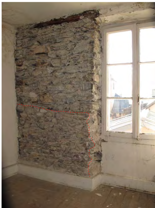
Fig. 35 Sion, Platea. Local R5c, paroi ouest. La paroi décrépie révèle une limite entre deux maçonneries différentes. Celle du haut (avec des blocs assez gros et contemporaine de la fenêtre) comprend des fragments de mortier brûlé qui proviennent probablement d'une hotte de cheminée démontée.
