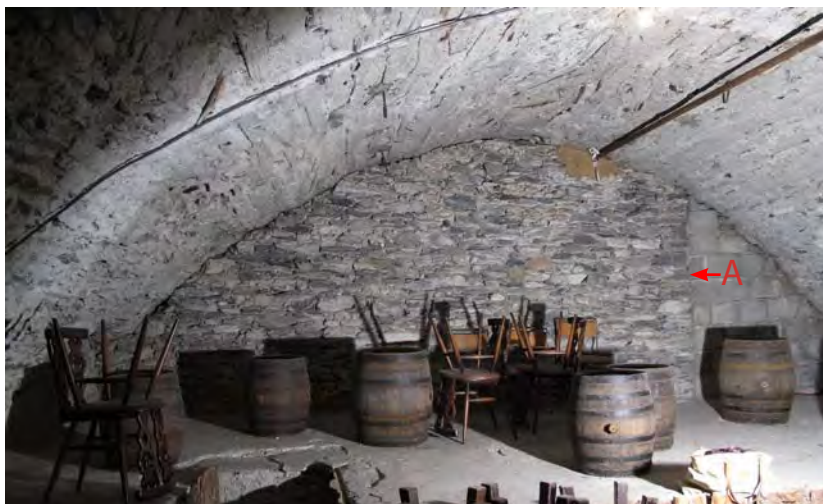
Fig. 13 Sion, Platea. Cave P2a, paroi ouest. Cloison postérieure à la grande voûte en berceau ; construite avec la cage d'escalier de l'annexe (P2b). A : piédroit parementé délimitant probablement un passage vers le palier d'escalier P2b'. Bouché lors de l'aménagement des WC sur le palier.
