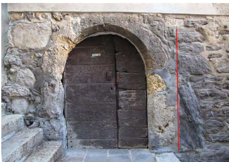
Fig. 9 Sion, Platea. Cave R1, façade nord, porte d'entrée. A côté du piédroit ouest en tuf, le montant en blocs de quartzite d'une porte antérieure probablement d'origine.
