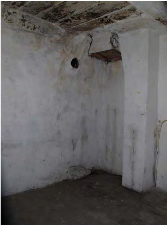
Fig. 22 Sion, Platea. Cuisine R3a, angle sud-ouest. Vestiges de l'âtre de la cuisine avec négatif de la hotte au-dessus du trou pour le tuyau de poêle.
