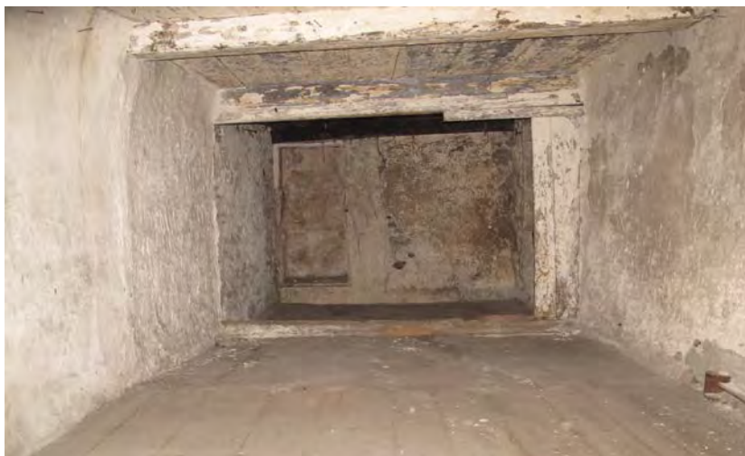
Fig. 10 Sion, Platea. Local R2, paroi sud. Au fond, reste d'une cloison en bois, comprenant une porte au centre (usure de la sablière basse). Sur le crépi de la paroi ouest (antérieur à la cloison) est gravée la date « 1612 ».
