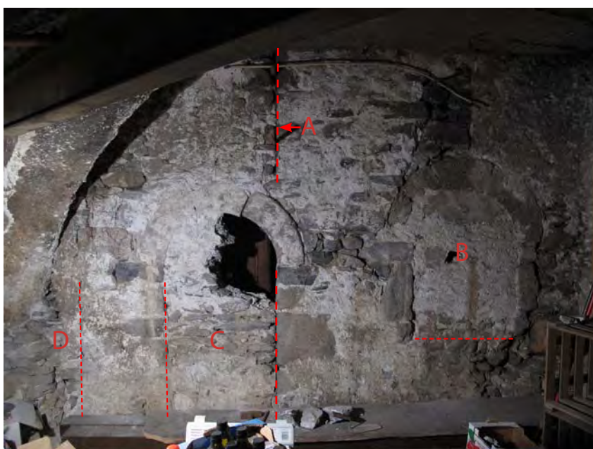
Fig. 12 Sion, Platea. Cave M2d, paroi nord (= façade sud des bâtiments P - R, au niveau de la cour intérieure). A : angle sud-ouest de la maison-tour P. B : fenêtre arquée de la tour. C : fenêtre de l'annexe ; son arc est ancré dans l'angle de la tour. D : montant d'une troisième ouverture formant avec l'ouverture « C » une fenêtre géminée.
