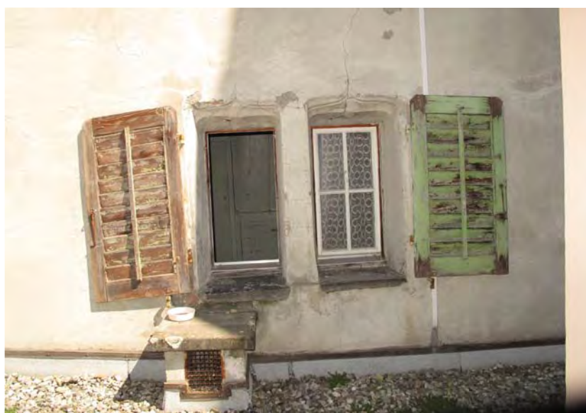
Fig. 29 Sion, Platea. Façade ouest, fenêtre double à meneau du local R4b. Chaque ouverture est surmontée d'une moulure en accolade façonnée dans du mortier à l'anhydrite. C'est la seule occurrence visible de ce genre de moulure dans la façade.
