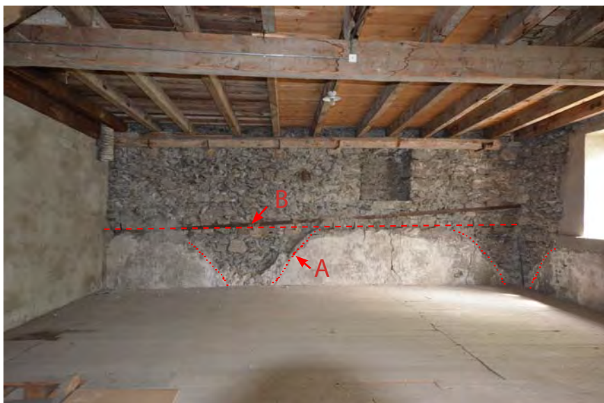
Fig. 31 Sion, Platea. Local P4a, paroi nord. Au bas de la paroi les restes de crépi permettent de restituer la forme des voûtains qui couvraient autrefois la salle d'apparat (P3a). A : tracé des voûtains. B : supports en fer d'un plafond de bois remplaçant les voûtes.
