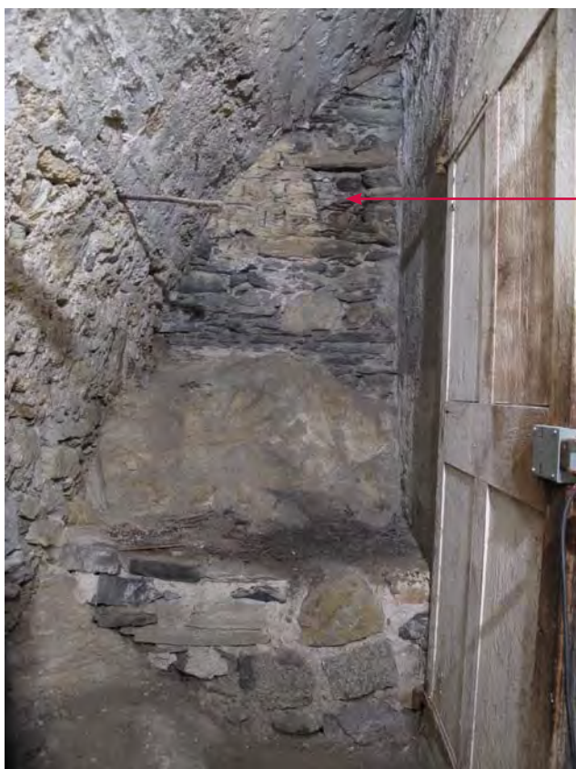
Fig. 2 Sion, Platea. Cave P1e, paroi sud. Les maçonneries des parois sud et nord de la tour sont chaînées et liées avec le même mortier. A : encoche pour le logement d'un sommier ; pris d'origine dans la maçonnerie, comme la niche symétrique au nord. Antérieur aux voûtes de P1d-e, il devait porter le plancher primitif de la maison-tour.
