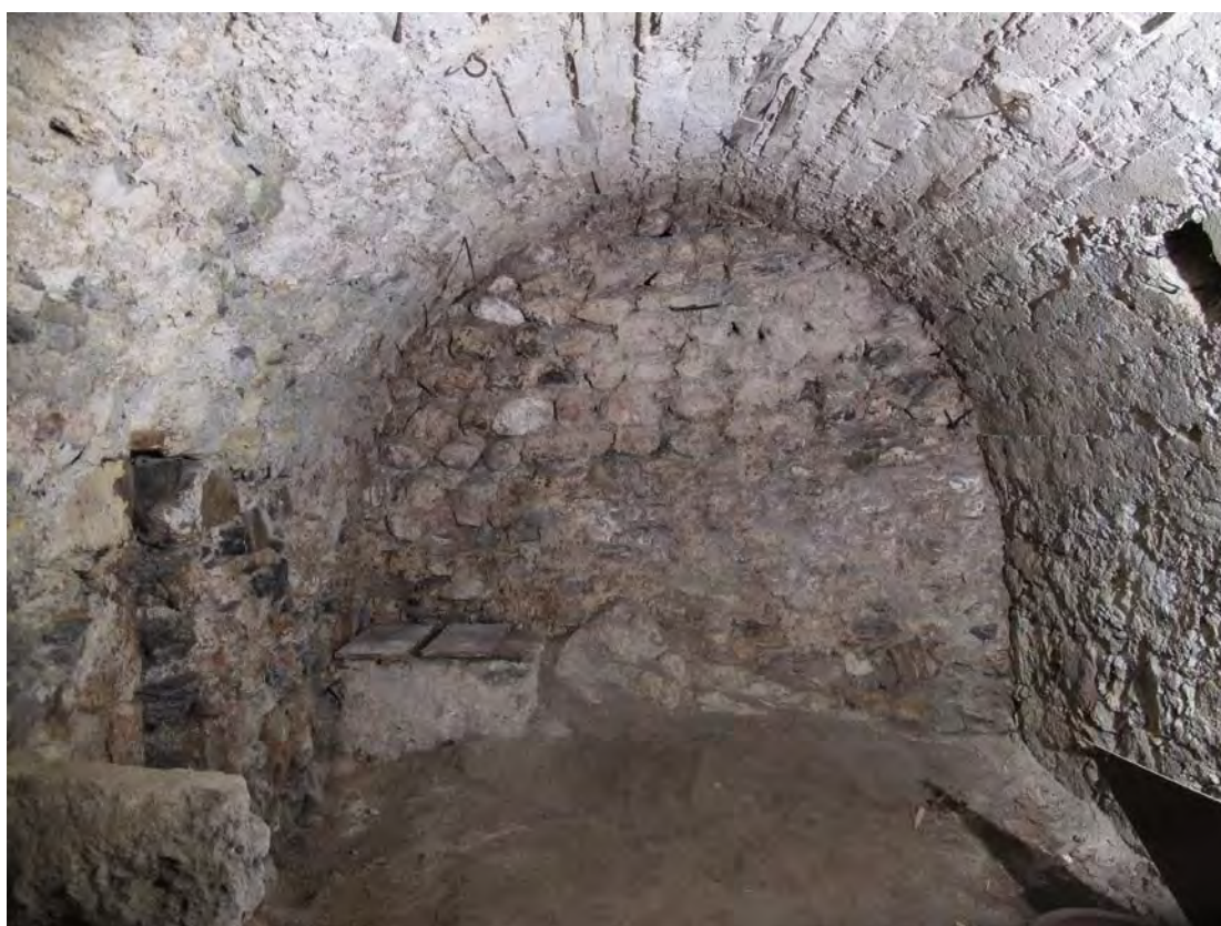
Fig. 5 Sion, Platea. Cave P1d, paroi est. Bien que d'aspect différent, les maçonneries de la paroi est et de la paroi nord (à gauche) sont chaînées l'une à l'autre. La voûte et la paroi à droite sont postérieures.
