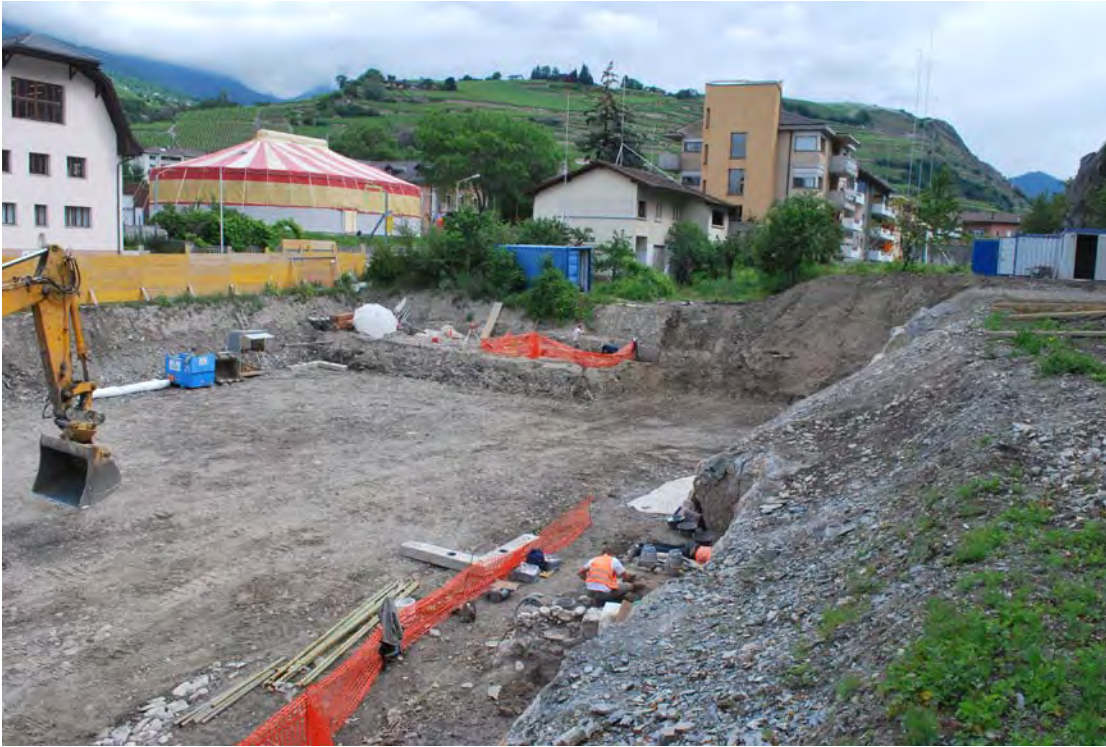
Fig. 9 – Sion, Le Rocher 1. Vue générale du chantier, partie sud et est, à mi-juin 2012. Le terrassement est pratiquement terminé. Restent deux petits secteurs en cours de fouille, au premier plan contre le rocher (inhumations du Haut-Moyen-Âge, fouille Tera sàrl) et au centre de l'image, fin de la zone 7. Au fond, la petite villa blanche (16, rue de Loèche) fera place au bâtiment Le Rocher 2 dont on aperçoit les gabarits.
