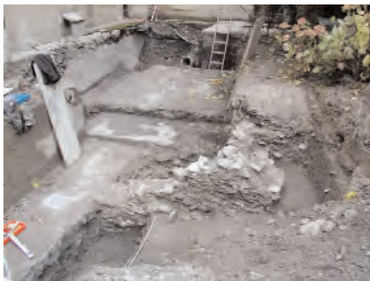
Fig.6 Sion, tranchée au nord de la Cathédrale. Détail du mur M1 (face est); à l'arrière-plan, la dalle en béton qui couvre les installations de chauffage.
