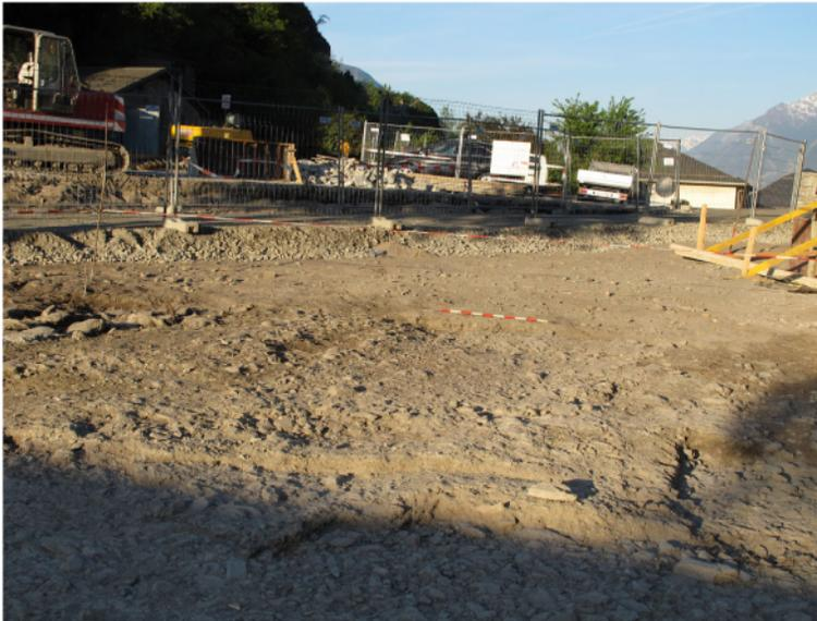
**Fig. 15.** Sion, Place Zermatten. En lumière rasante, les ornières à la surface de la dernière recharge UT41 de la voie de roulement.
