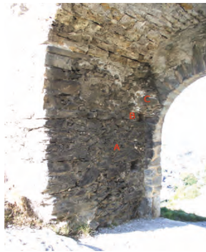
Fig. 5 Fortifications occidentales : porte, embrasure sud. A : le trou pour la barre de verrouillage est ménagé dans une réfection du parement. B : négatif d'une poutre horizontale qui soutient une maçonnerie ( C ) doublant l'ancienne. Cette transformation est sans doute liée à l'installation d'une porte rectangulaire.
