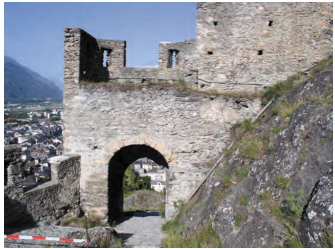
Fig. 3 Fortifications occidentales : porte, face interne.
