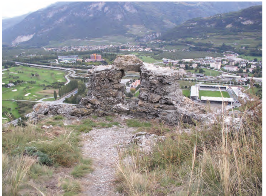
Fig. 24 Fortifications orientales, muraille du flanc est sur le replat inférieur. Merlon avec meurtrière (face interne).
