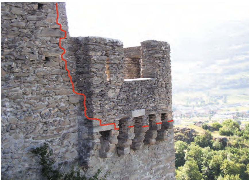
Fig. 5 Fortifications occidentales : porte, embrasure sud. A : le trou pour la barre de verrouillage est ménagé dans une réfection du parement. B : négatif d'une poutre horizontale qui soutient une maçonnerie ( C ) doublant l'ancienne. Cette transformation est sans doute liée à l'installation d'une porte rectangulaire.
