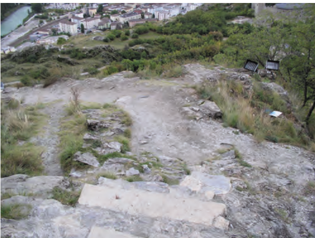
Fig. 32 Tronçon supérieur du chemin devant la porte du château (fig. 25,H). Le chemin est bordé sur les deux bords par un muret de soutènement ; entre les deux les restes d'un pavage.
