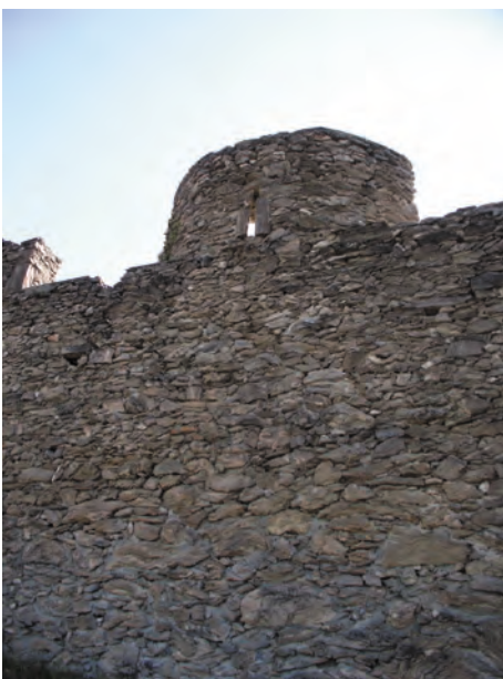
Fig. 9 Fortifications occidentales : Détail de la tour, face extérieure se distinguant de la muraille uniquement au niveau du merlon arrondi.
