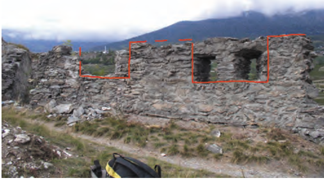
Fig. 16 Fortifications orientales, muraille du flanc nord. Le tracé rouge indique l'emplacement des merlons primitifs.
