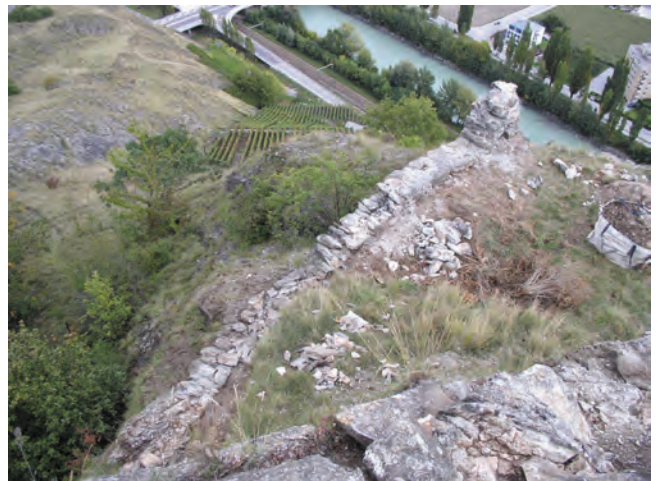
Fig. 21 Fortifications orientales, muraille du flanc est sur le replat inférieur.
