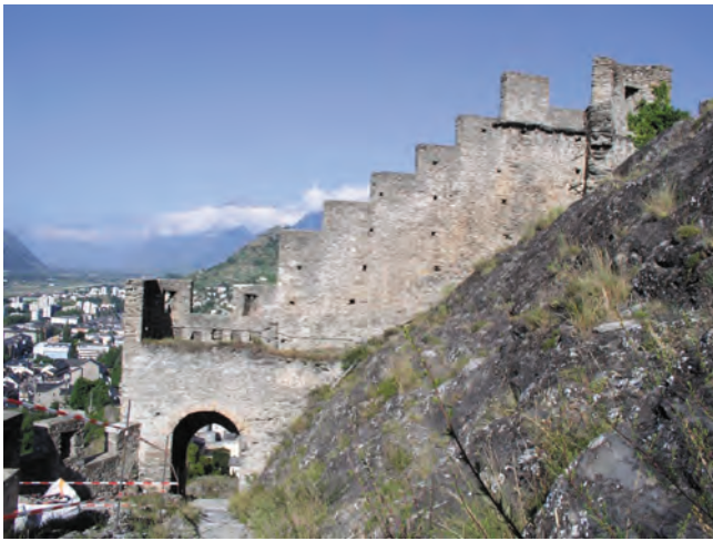
Fig. 2 Fortifications occidentales : vue générale de la face interne.
