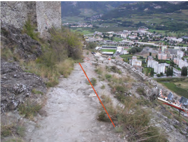
Fig. 30 Tronçon supérieur du chemin (fig. 25,G). Le chemin actuel croise le muret de soutènement de l'ancien tracé. En rouge : bord extérieur du muret de soutènement.
