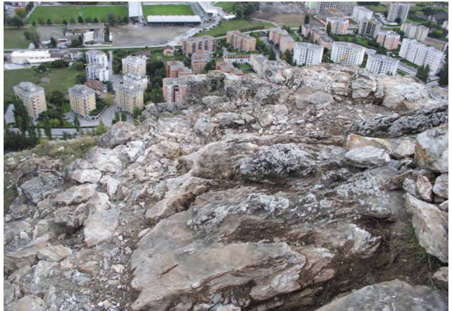
Fig. 19 Fortifications orientales, maçonnerie de la tour après nettoyage. Vue depuis le haut, vers l'est.
