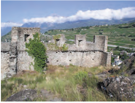
Fig. 11 Fortifications occidentales : vue générale de l'extrémité nord.
