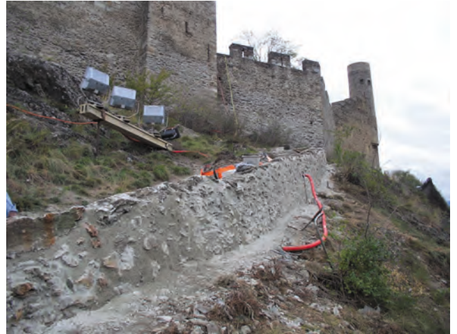
Fig. 29 Chemin à la hauteur du dernier virage (fig. 25,F). Face extérieure du muret de soutènement après sa consolidation en 2005.
