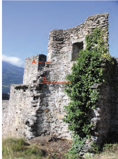
Fig. 12 Fortifications occidentales : Détail de la tour, face intérieure. A : tablette du créneau. B : ressaut indiquant le niveau d'un plancher.
