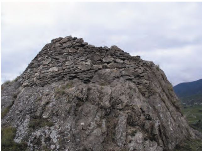
Fig. 20 Fortifications orientales, maçonnerie de la tour. Vue depuis l'est.
