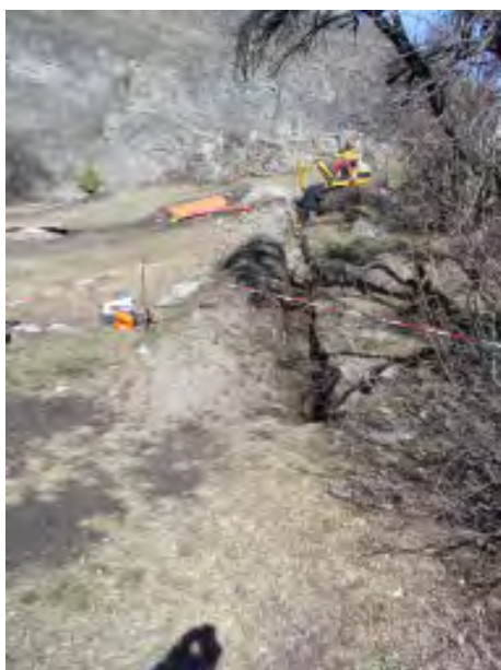
Fig. 4 Sion, Valère « En Prélet ». Tranchée (D) en cours de creusement. Vue depuis le sud.
