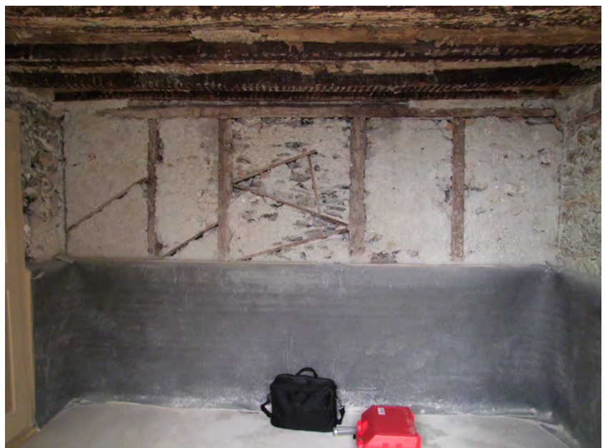
Fig. 53. Sion, Gd-Pont 8. 1 er étage, local 4 (chambre occidentale), Paroi est. Subdivision secondaire de l'ancienne annexe. Le panneau central, plus large, pourrait avoir servi de passage dans un premier temps (durant les travaux ?).
