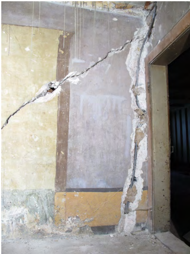
Fig. 24. Sion, Gd-Pont 8. 1 er étage, local 6 (vestibule). Paroi ouest. Maçonnerie constituée de matériaux de démolition en remploi liée au plâtre gris, épaisseur 18 cm.
