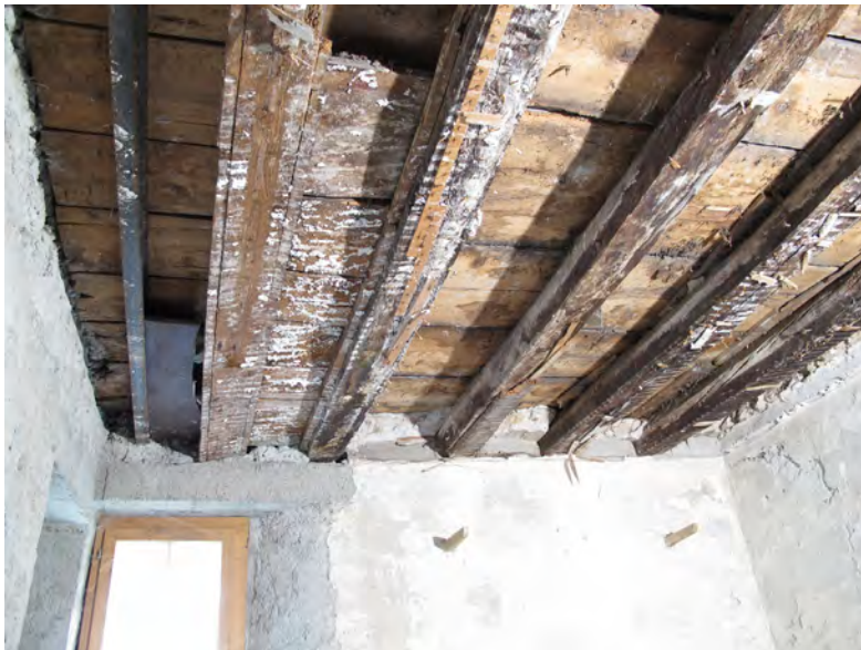
Fig. 49. Sion, Gd-Pont 8. 1 er étage, local 5 (chambre est). Plafond (vu vers le sud). Les trois solives de droite semblent plus anciennes et sont moulées par le stuc de l'entrevous. Les deux solives de gauche sont sans doute contemporaines de l'agrandissement de l'annexe
