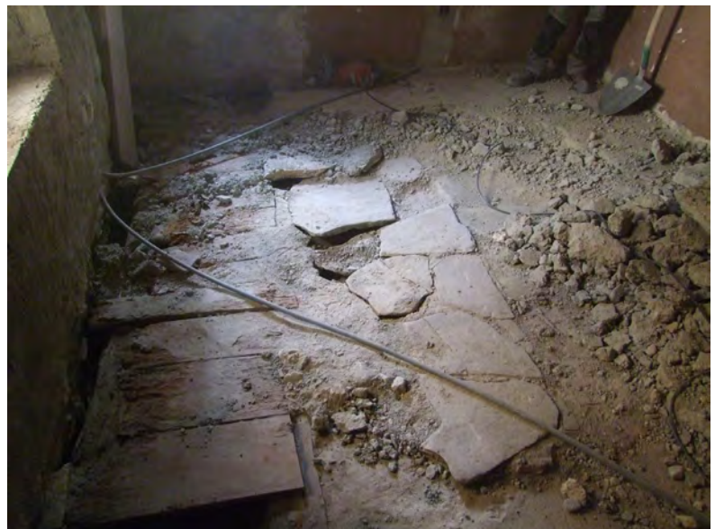
Fig. 47. Sion, Gd-Pont 8. 1 er étage, local 5 (chambre est). Détail du sol (vu vers le sud). Sous la chape en mortier, de petites planches et des dalles égalisant la surface après l'affaissement des premiers deux entrevous.
