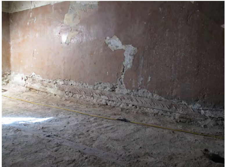
Fig. 48. Sion, Gd-Pont 8. 1 er étage, local 5 (chambre est). Paroi ouest. Le galandage repose sur un (voire deux?) sols en mortier plus anciens.
