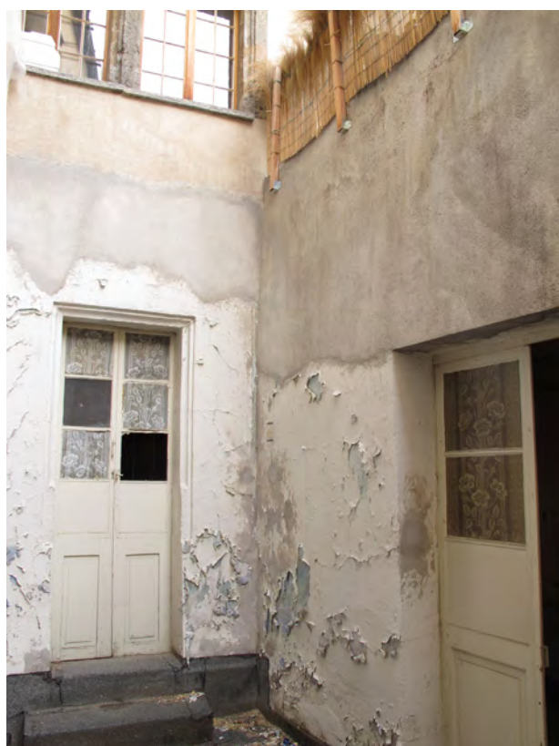
Fig. 13. Sion, Gd-Pont 8. 1 er étage, façade sud, porte-fenêtre (f2) du local 3. Le cadre chanfreiné en tuf de l'ancienne fenêtre constitue la moitié supérieure de la porte. Il est identique à celui de la fenêtre en façade ouest.
