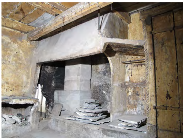
Fig. 11. Sion, Gd-Pont 8. 1 er étage, local 1 (cuisine), cheminée. L'âtre de la cuisine (phase III) avec le fourneau ajouté par la suite. Le sommier a été ajouté sous le solivage (extrémité ouest probablement percée dans la paroi maçonnée).
