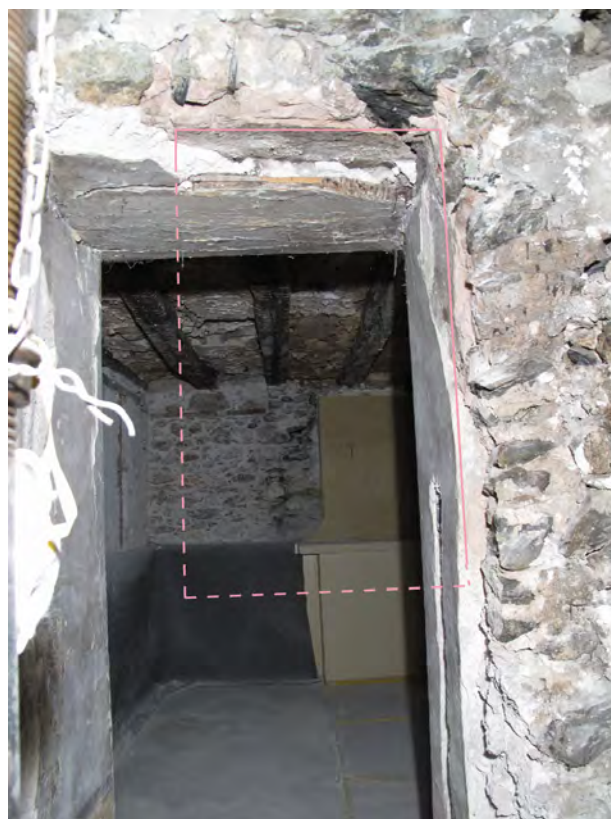
Fig. 14. Sion, Gd-Pont 8. 1 er étage, ancienne façade sud, fenêtre (f3, face nord). Sous le crépi de la porte reliant les locaux 3 et 4 est apparu le cadre en mortier au plâtre d'une ancienne fenêtre percée dans le mur.
