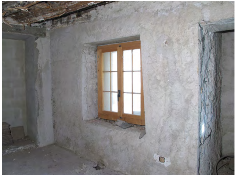
Fig. 51. Sion, Gd-Pont 8. 1 er étage, local 5 (chambre orientale). Paroi est. A gauche, le linteau de la Fenêtre a été surélevé de 20 cm par rapport à l'ouverture primitive. A droite, l'emplacement des anciennes latrines.
