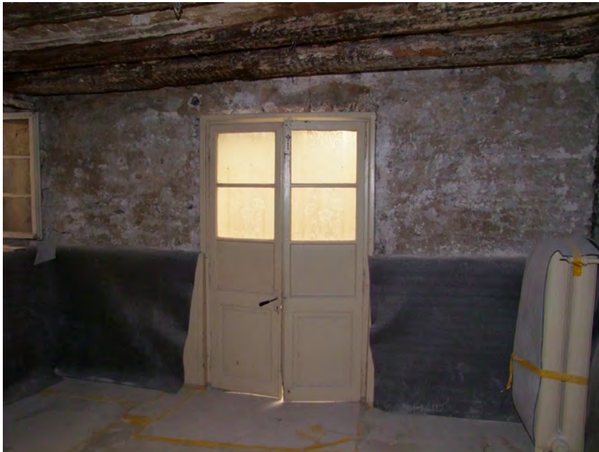
Fig. 52. Sion, Gd-Pont 8. 1 er étage, local 4 (chambre occidentale), Paroi ouest. Cette paroi peu épaisse. La porte semble avoir été percée récemment (montants en ciment).
