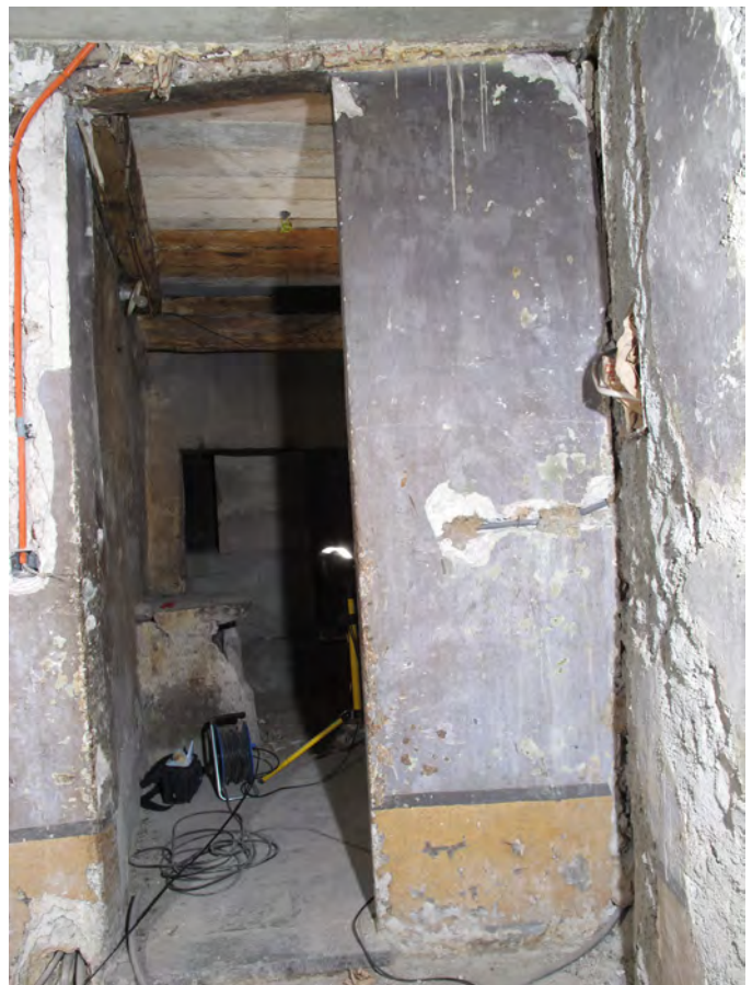
Fig. 25. Sion, Gd-Pont 8. 1 er étage, local 6 (vestibule). Paroi nord. La maçonnerie est adossée à la boiserie du local 2 et englobe les deux sommiers. Elle comprend dès le départ les portes menant à la grande salle et la cuisine.
