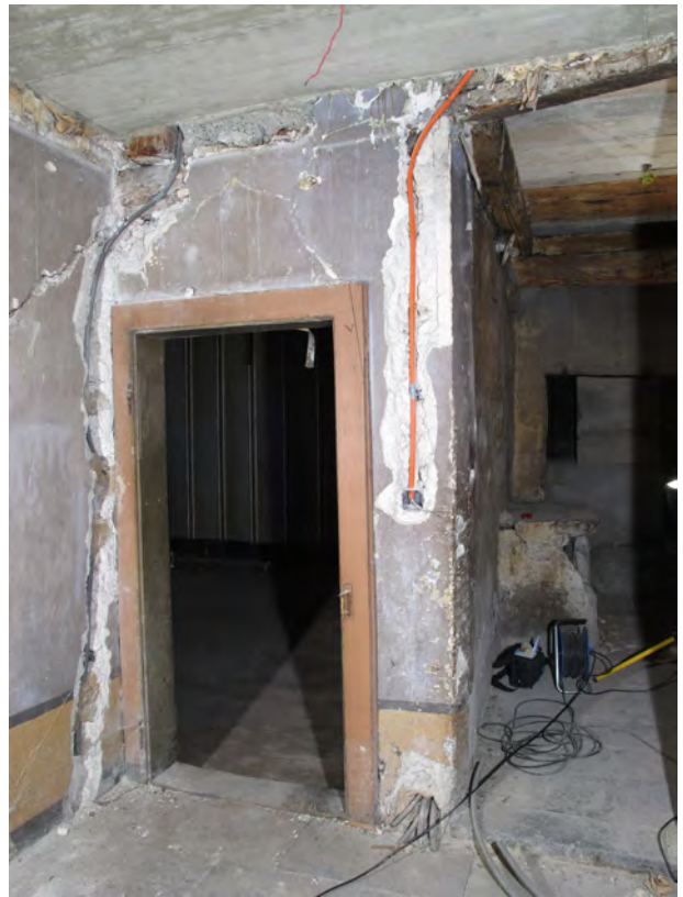
Fig. 25. Sion, Gd-Pont 8. 1 er étage, local 6 (vestibule). Paroi nord. La maçonnerie est adossée à la boiserie du local 2 et englobe les deux sommiers. Elle comprend dès le départ les portes menant à la grande salle et la cuisine.
