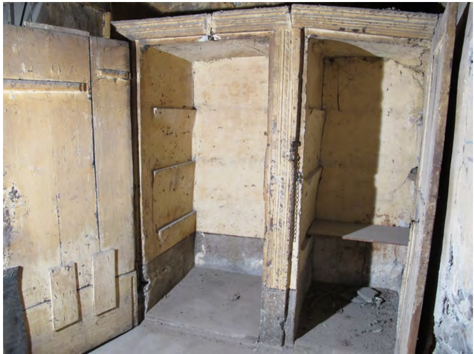
Fig. 45. Sion, Gd-Pont 8. 1 er étage, local 1 (cuisine). Paroi nord. Intérieur de l'armoire double avec les supports maçonnés des étagères.
