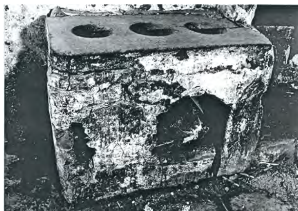
Fig. 12. Sion, Gd-Pont 8. 1 er étage, local 1 (cuisine), fourneau (état 1984). La partie inférieure maçonnée était dotée d'une ouverture avec ventail métallique pour le chargement des braises et la vidange des cendres. La plaque de cuisson avec les trous pour les casseroles était en pierre.
