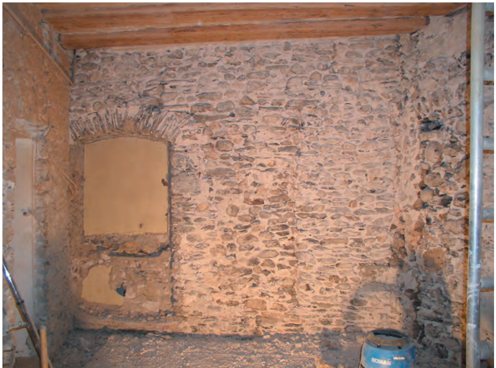
Fig. 8. 1 er étage, cuisine, mur nord, vue générale (2010).
