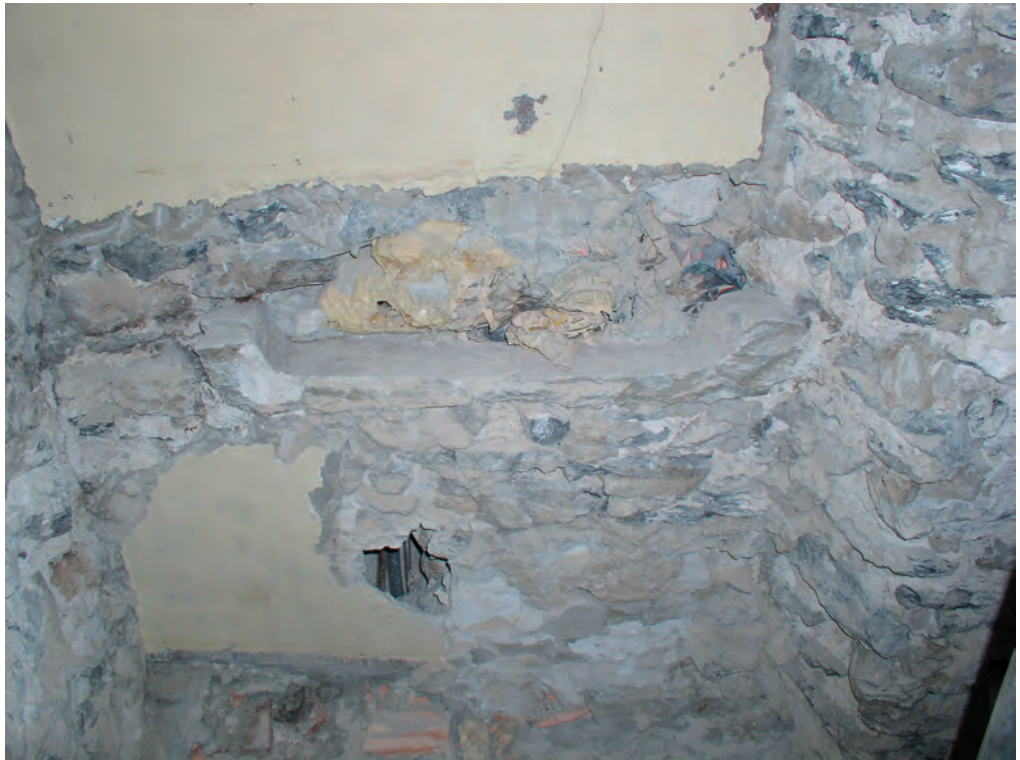
Fig. 9. 1 er étage, cuisine, mur nord, détail de l'évier (2010).
