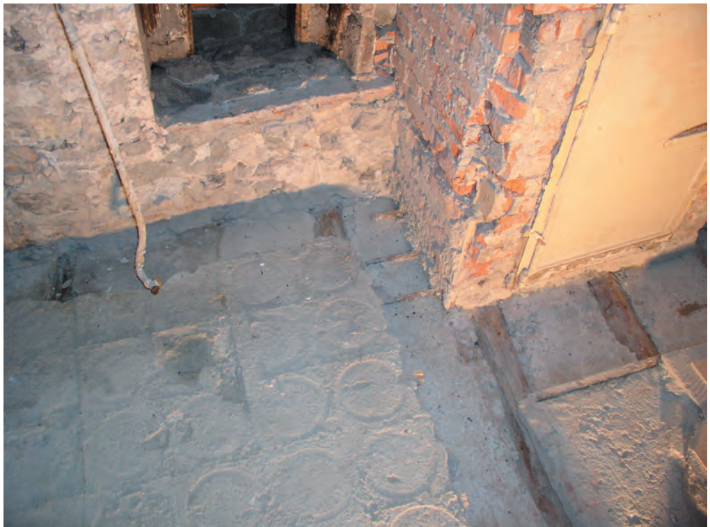
Fig. 16. 1 er étage, cuisine, sol : sous le sols actuel, on voit les solives du sol primitif (2010).
