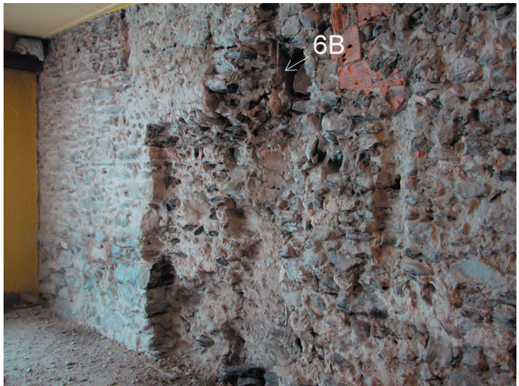
Fig. 3. Rez-de-chaussée, restaurant salle nord, mur sud (vue vers l'est 2010).
