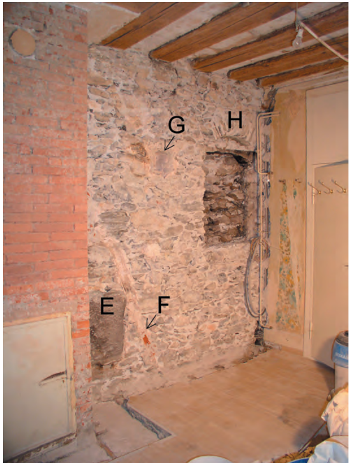
Fig. 11. 1 er étage, cuisine, mur est, vue générale vers le sud (2010).
