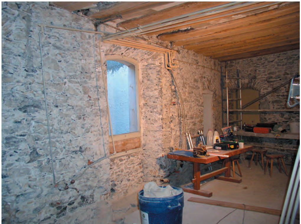
Fig. 6. 1 er étage, cuisine, mur ouest, vue vers le nord (2010).
