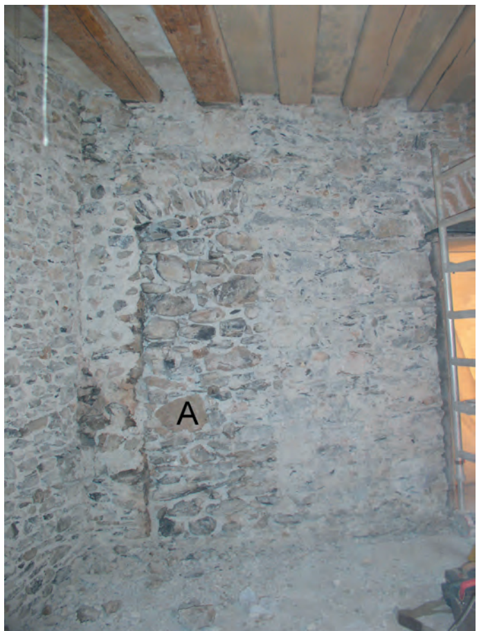
Fig. 12. 1 er étage, cuisine, mur est : à gauche, on devine l'ancien mur nord dont l'arrachement est rhabillé de mortier stuqué. Le parement de ce mur sert de piédroit d'une ancienne porte (A) bouchée lors de la mise en place de la porte plus récente (B) à droite.
