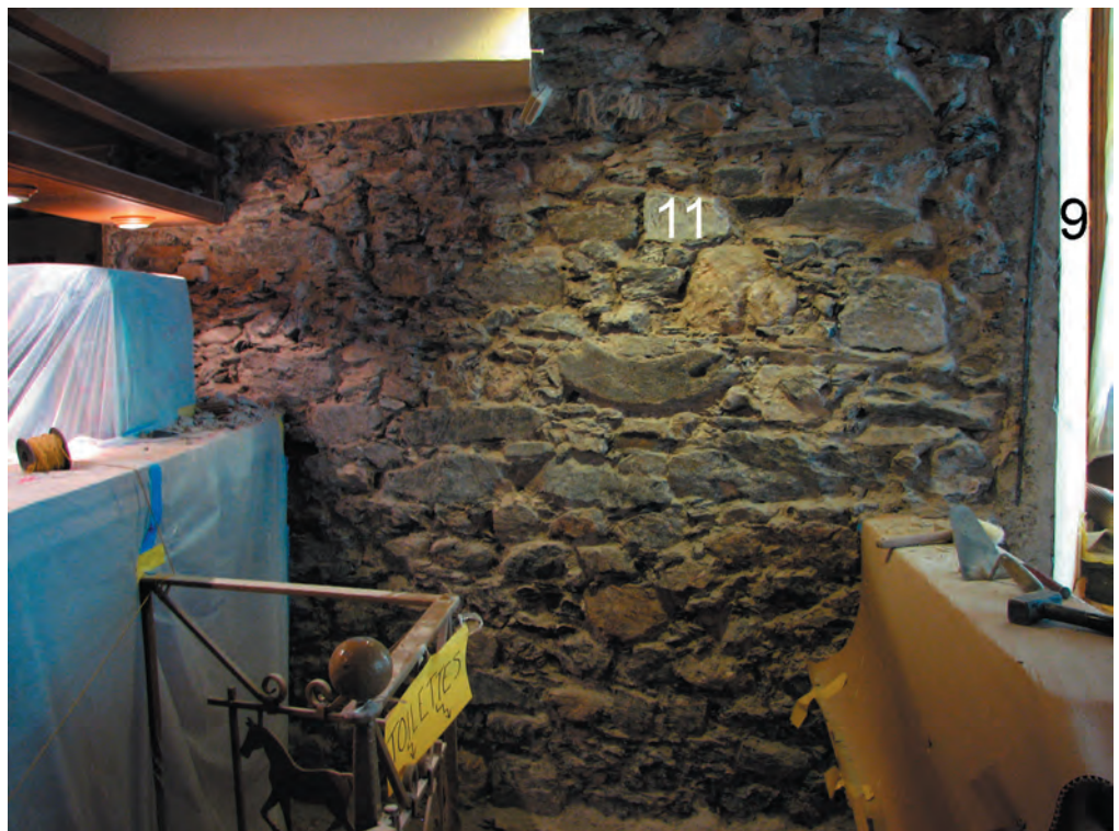
Fig. 4. Rez-de-chaussée, restaurant salle sud, mur nord (2010).
