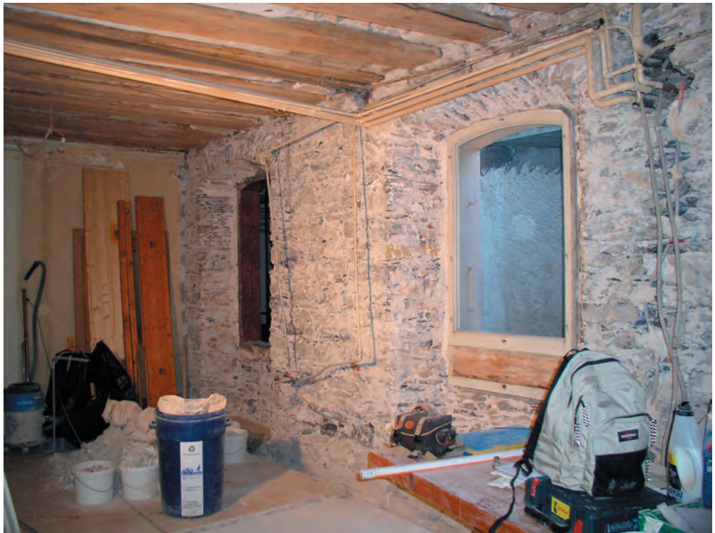
Fig. 5. 1 er étage, cuisine, mur ouest, vue vers le sud (2010).
