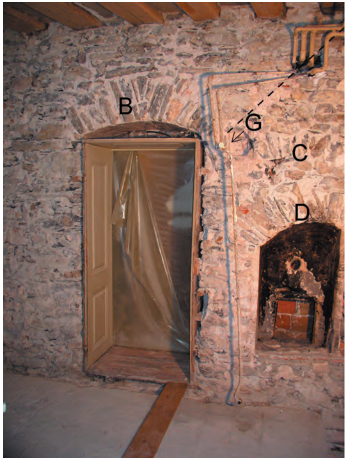
Fig. 13. 1 er étage, cuisine, mur est : l'ouverture (C) est insérée dans la maçonnerie plus ancienne, la porte (B), l'ouverture de chargement d'un fourneau (D) et le cadre de la hotte (G) dans la maçonnerie plus récente (2010).
