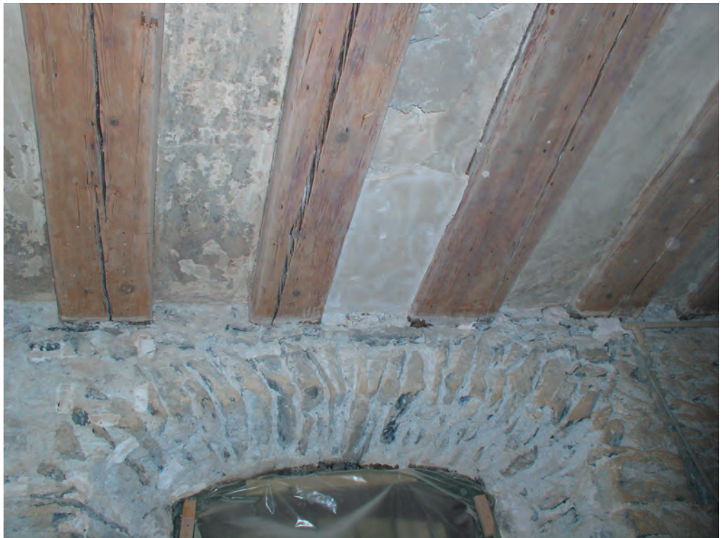
Fig. 7. 1 er étage, cuisine, plafond : les solives sont posées sur un lit de réglage qui surmonte le mur ouest, antérieur à la construction du plafond (2010).
