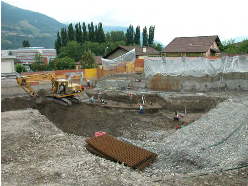
Fig. 1 Vue générale du chantier en direction du sud.
