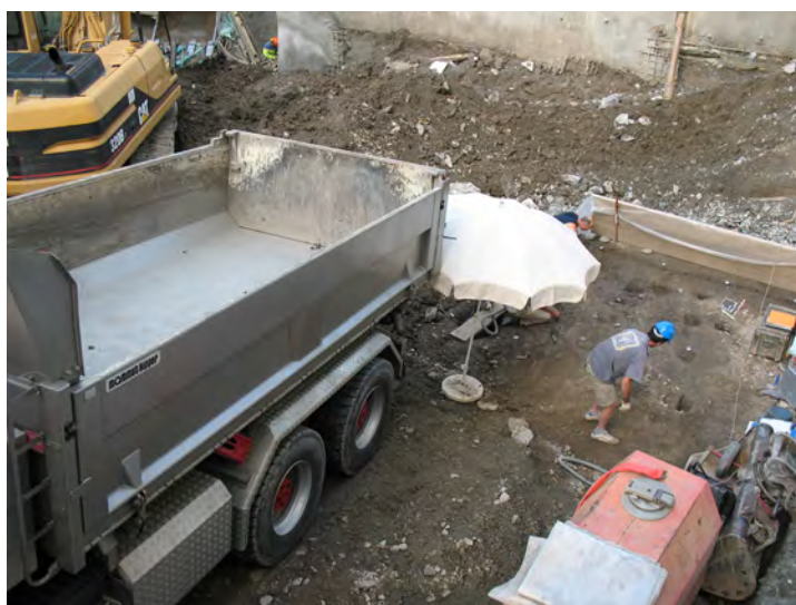
Figure 14. Vue de la Zone 1 en cours de fouille le 25 juillet 2007.
