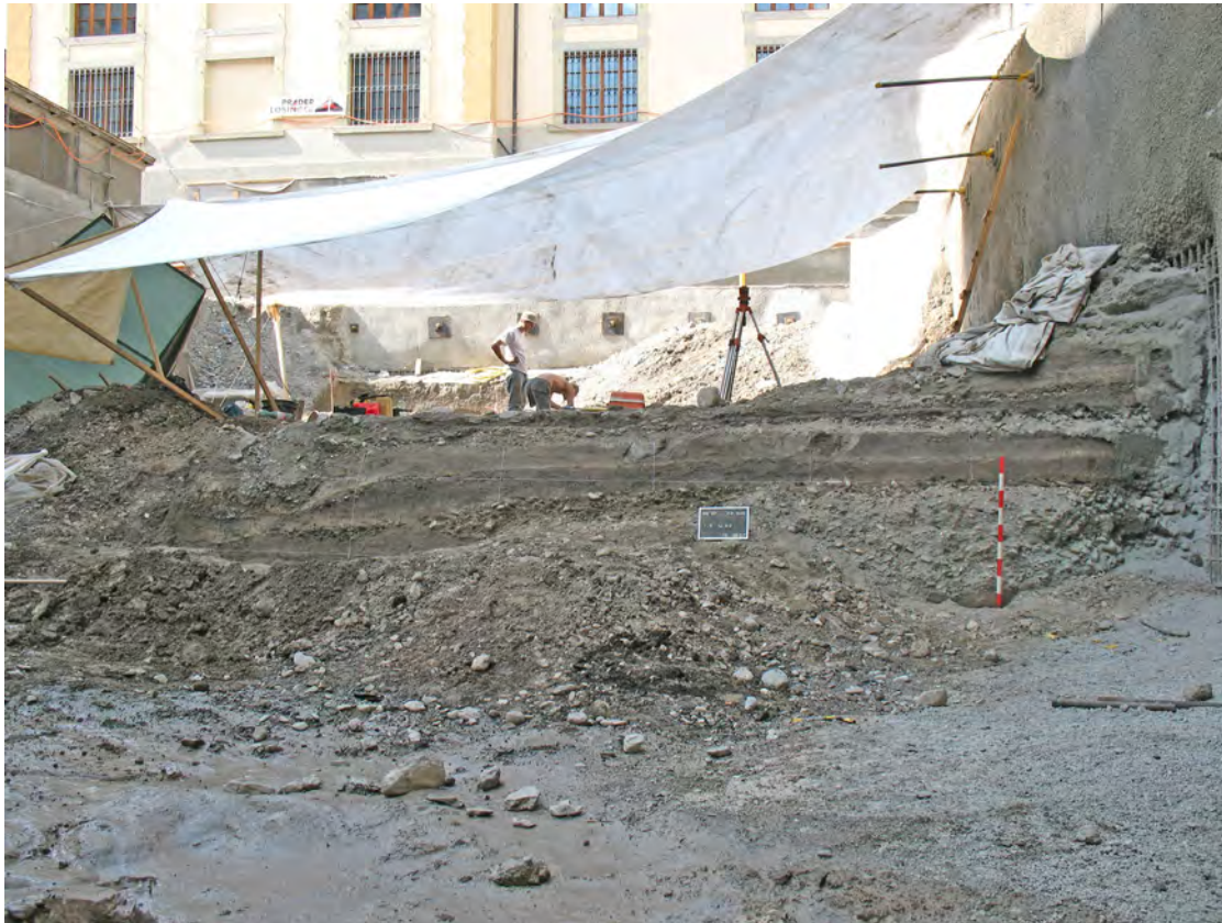
Figure 28. Vue du profil sud de la Zone 3 (coupe STG14), avant le creusement de la Tranchée Tr.8, le 13 août.
