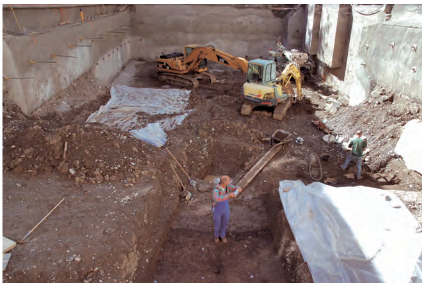
Figure 16. Vue du chantier de fouille en direction du sud, le lundi 30 juillet 2007. Au premier plan au centre, Zone 1, prolongement de la Tranchée Tr.5 vers le nord. La Zone 3, au centre de l'image, à gauche, est protégée après le décapage à la pelle mécanique.
