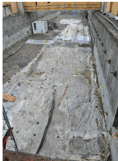
Fig. 13 — Les orages estivaux parfois violents ont obligé à protéger minutieusement les niveaux archéologiques et à évacuer fréquemment les eaux de pluie avec une pompe et au moyen de puisards creusés dans les alluvions sous-jacentes.
