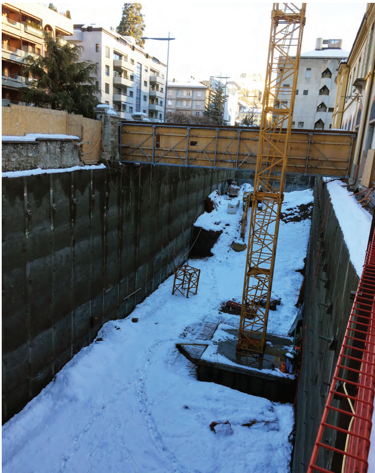
Fig. 14 — Le fond de l'excavation à 13,50 m sous le sol actuel a été atteint au mois de décembre 2017 dans les zones 1, 2 et 3.
