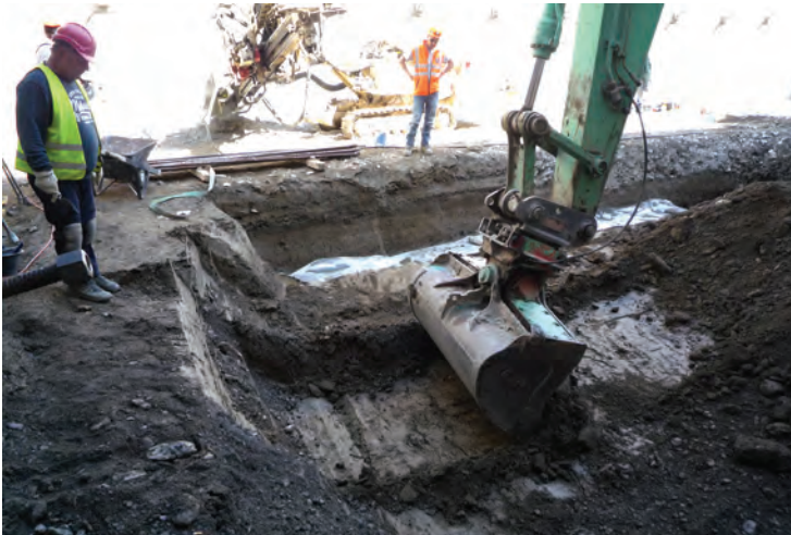
Fig. 8 — Dans la zone 1 Sud, l'excavation sur le niveau le plus ancien N1 a été réalisée directement à la pelle mécanique.
