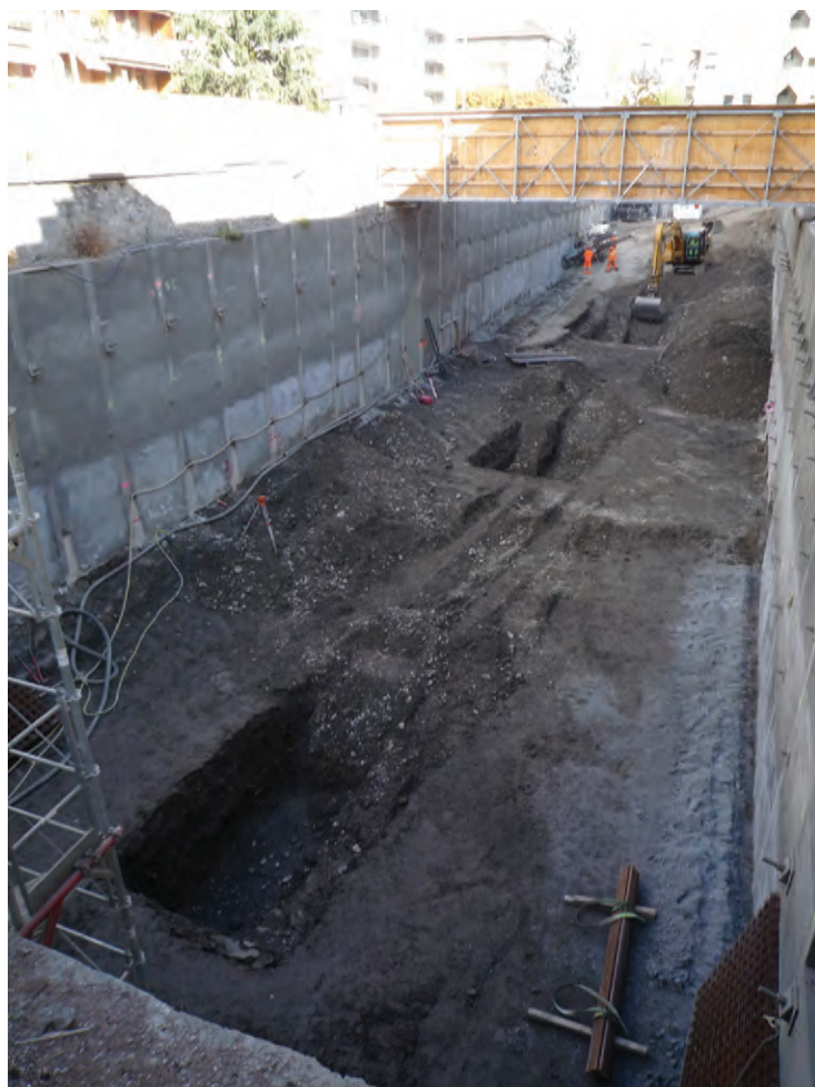
Fig. 15 — Excavation des sondages de l'étape 4 (S1.4, S2.4 et S3.4).
