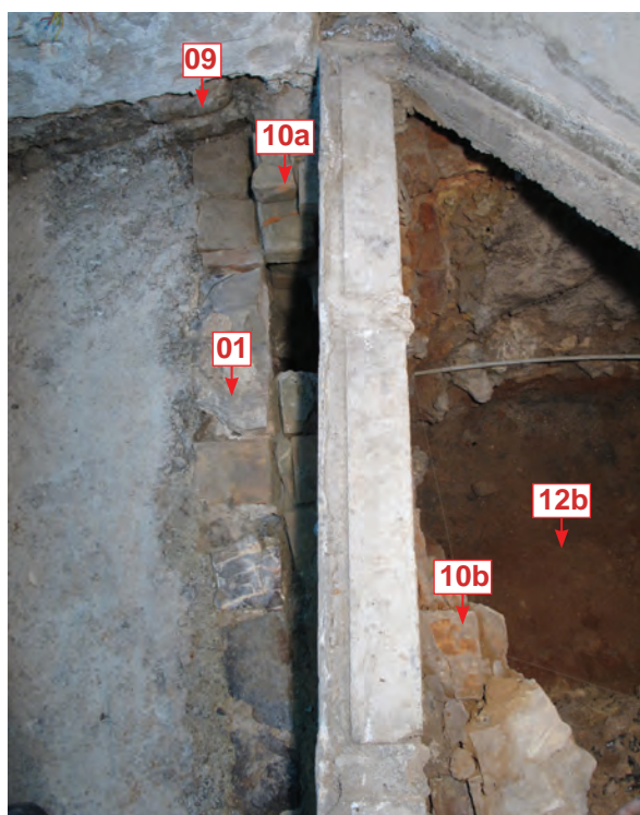
Fig. 12. Maison du Diable, four de potier. Angle nord-est de la chambre de chauffe. La paroi en brique du foyer (10a, 10b) double le muret nord du laboratoire (01), lui-même adossé au mur est (09) du pavillon. A droite, le terrain naturel (12b) rubéfié par la chaleur du four. Vue vers l'est.
