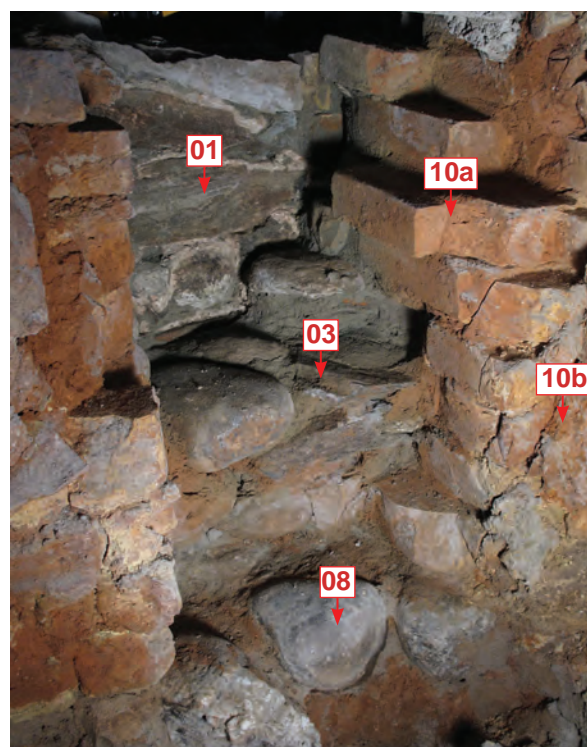
Fig. 13. Maison du Diable, four de potier. Paroi nord de la chambre de chauffe. Les parois en brique du foyer (10a, 10b) prennent appui sur l'ancien sol en boulets (08) de la pièce et sont adossés au mur extérieur du four (01) dont ils recouvrent le ressaut de fondation (03).
