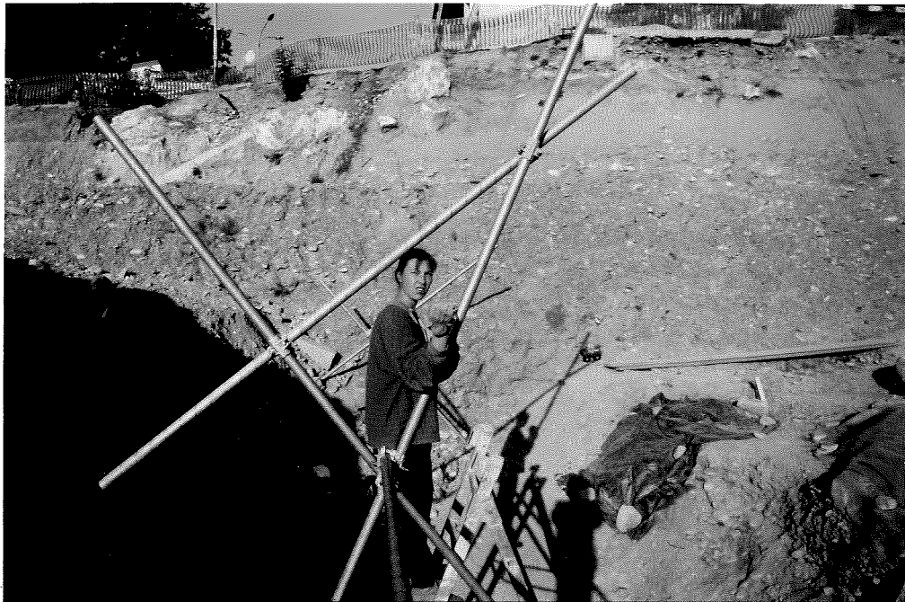
Installation du chantier: montage de la structure en tubes servant de support au carroyage.
