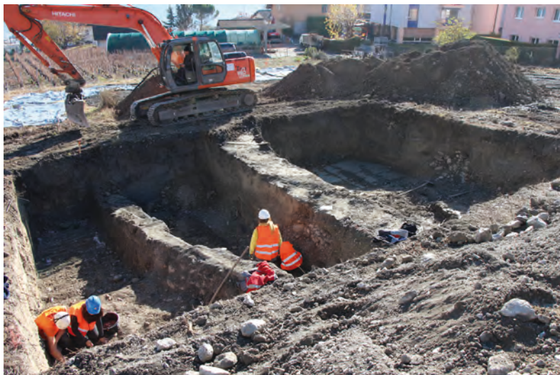
Fig. 6. Vue vers le sud de la fouille à l'issue des derniers décapages à la machine. Vue vers le sud-ouest.
