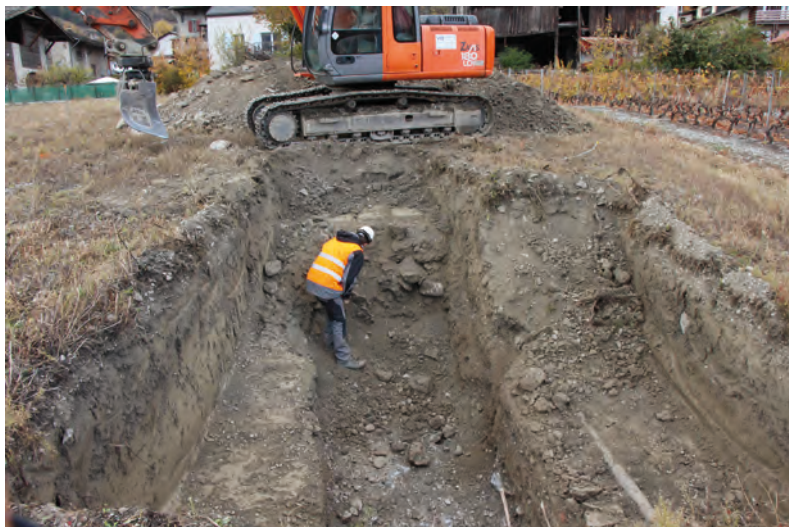
Fig. 2. Découverte du mur en pierre sèche de la phase IIb (UT002) lors de la réalisation du sondage 6. Vue vers le nord-ouest.
