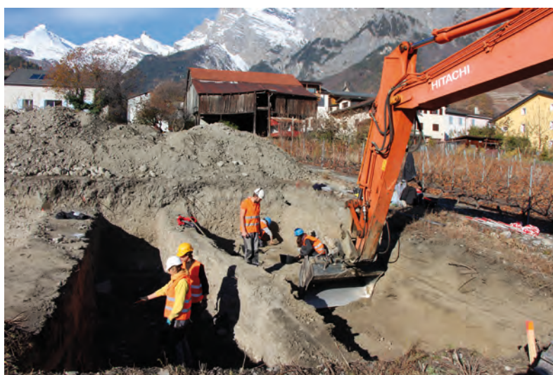
Fig. 5. Décapage machine et début de la fouille du secteur est. Vue vers le nord-ouest.
