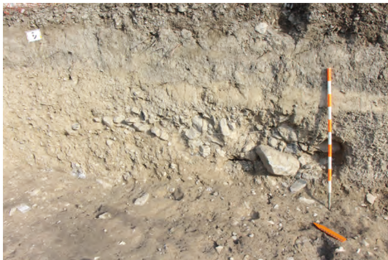
Fig. 14. Secteur Est Vue de la STG003 avec les restes du mur de la phase IIb (UT002). Vue vers le nord-est.
