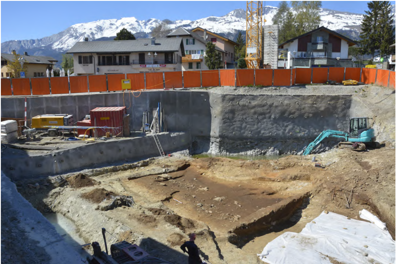
Fig. 9. Zone d'intervention une fois le terrassement réalisé autour du périmètre.
