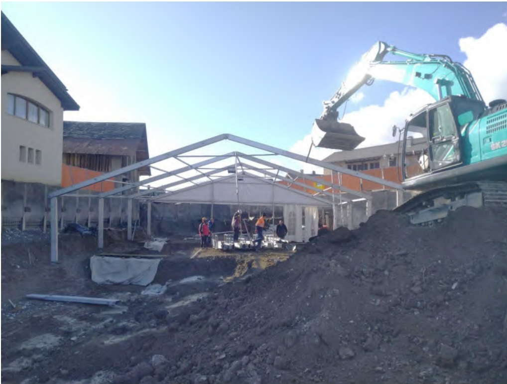
Fig. 5. Installation de la tente de protection.
