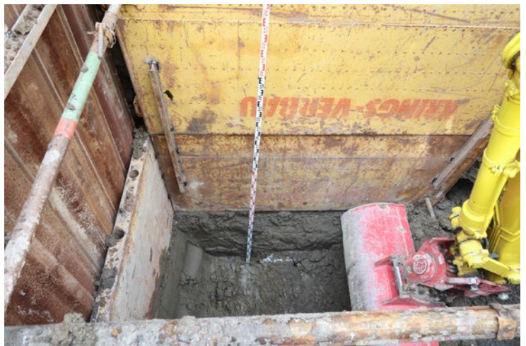
Fig. 2 – St-Maurice, cure. Dans la fouille effectuée pour y implanter un tube d'égout à -4 m de profondeur, les silts des dépôts lacustres sont visibles tout au fond, sous le bord du blindage jaune. Vue du nord.
