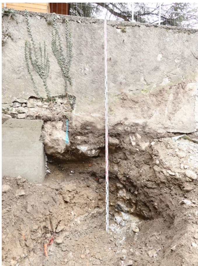
Fig. 5 – St-Maurice, cure. Etape de travail dans le sous-murage du mur de soutènement du parvis. Vue de l'ouest.
