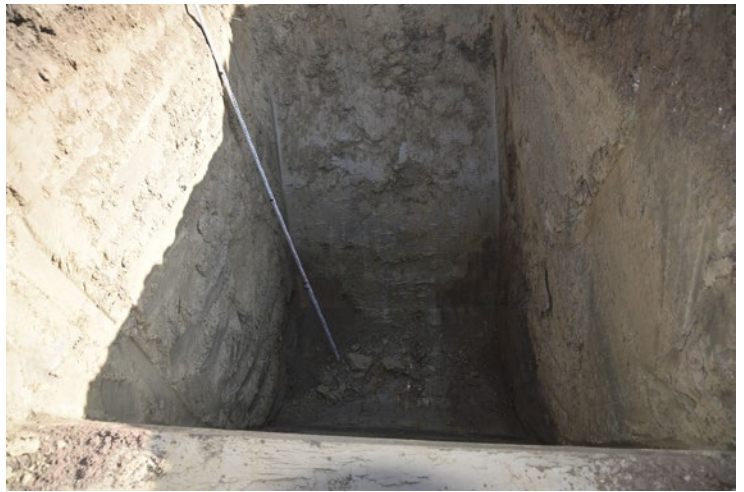
Fig. 1 – Sondage profond (- 4 m) effectué dans le sous-sol du chantier St-Laurent 2023. Les silts des dépôts lacustres sont visibles sur toute la hauteur de la coupe. Vue du sud.
