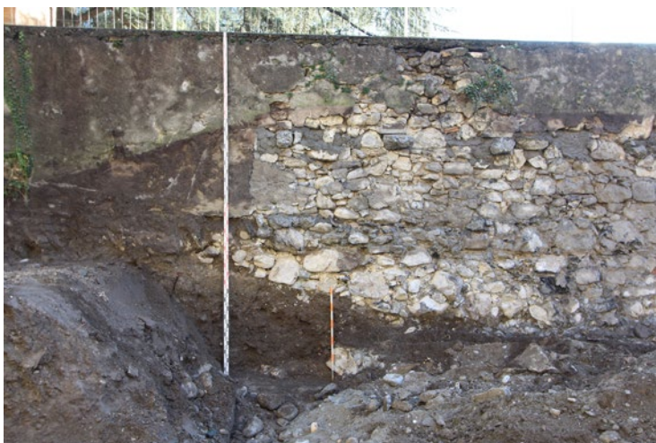
Fig. 27 – St-Maurice, cure. Face ouest du mur de soutènement du parvis. La fondation n'est pas implantée profondément et elle suit le pendage du terrain de l'époque. Vue de l'ouest. © OCA 2022.
