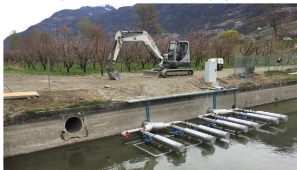
Pose de l'une des deux conduites principales (à gauche) et pompes installées dans le réservoir Faiss, au Grand Blettoy.
