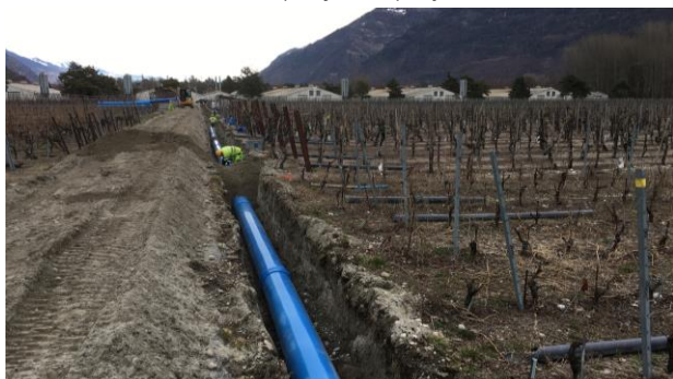
Pose de l'une des deux conduites principales (à gauche) et pompes installées dans le réservoir Faiss, au Grand Blettoy.
