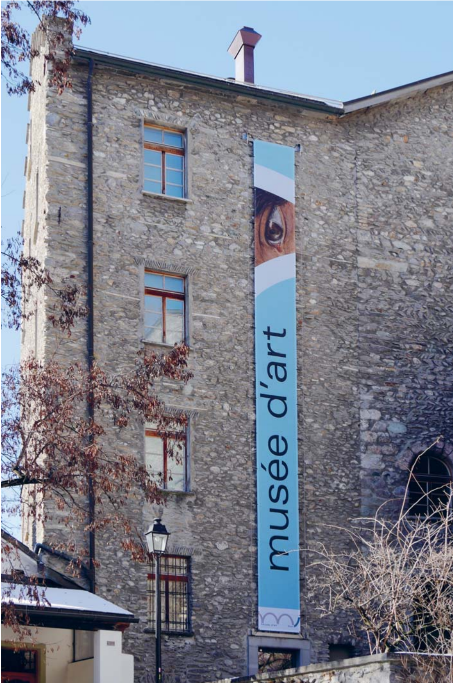
Die neue Banderole des Kunstmuseums an der Fassade. Vue de la façade avec la nouvelle banderole murale du Musée d'art.
