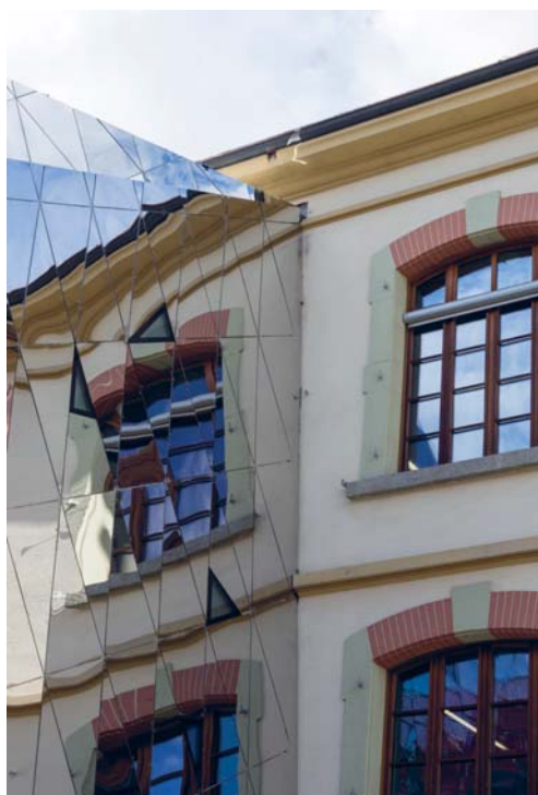
Les Arsenaux – PLI : bâtiment de liaison – extérieur. / Verbindungsgebäude ausserhalb.
