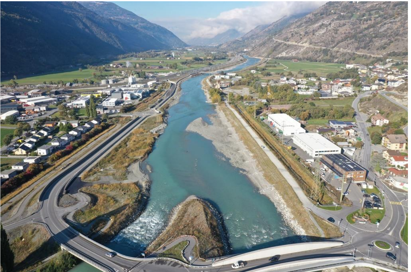
Confluence du Rhône et de la Viège vers Baltschieder, vue après la réalisation des travaux du projet R3 pour cette partie
